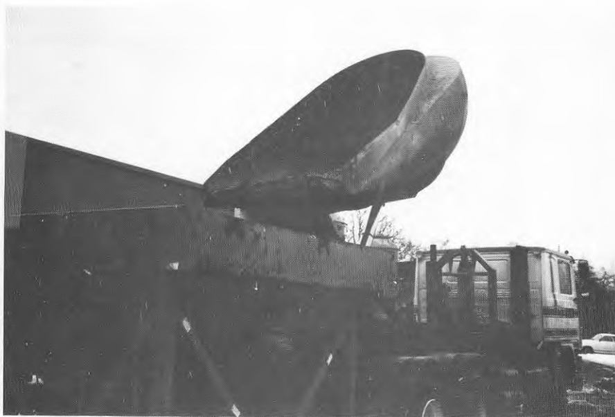
Figur 18 Tippning av trög betong i skruvblandningsfickan
