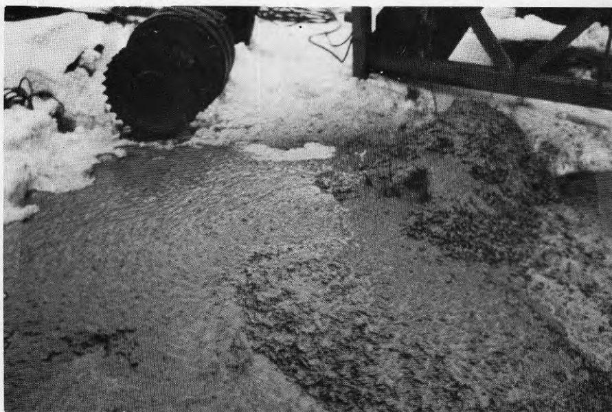
Figur 23 Olika konsistenser på betongen under försöket
