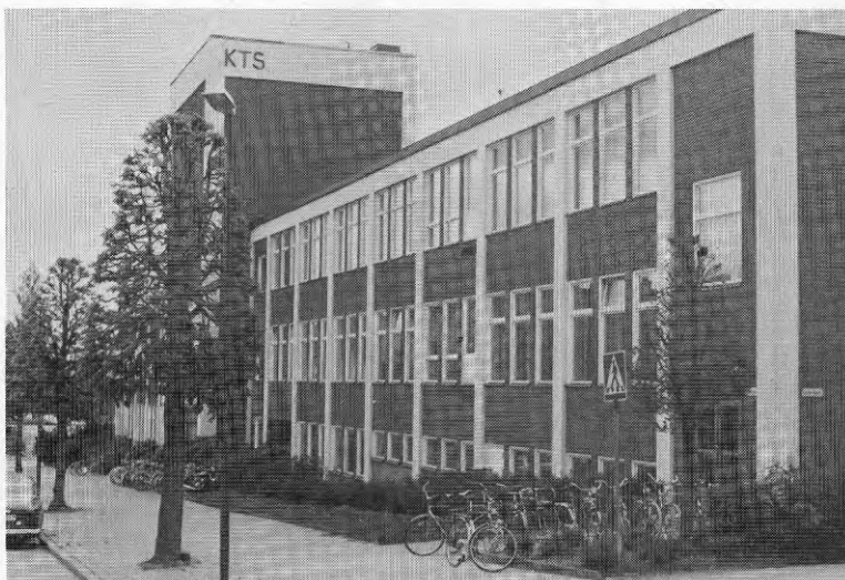
FIG 5.1 Tekniska skolans fasad mot gatan
