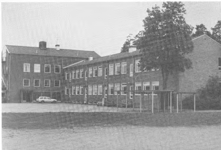
FIG 3:1 Huvudbyggnadens ostliga fasad, Malmen Skola, Kumla
