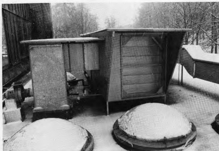
Figur 5.7. Fotografi av frånluftsaggregatet med uteluftsspjället stängt.
