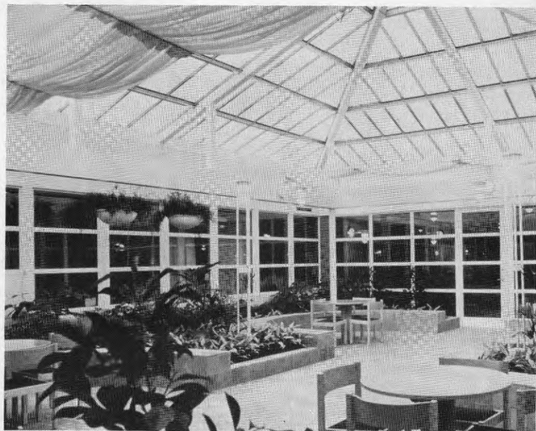
Bild 36 Ljuskärd i Lugnetskolan, Falun, med överglasningar i flera ljuskärdar och centralhallen. 1983 Arkitekt: J Hanssons ark kontor
