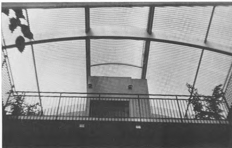
Bild 45 Ljuspanel av klar polykarbonat på limträstomme, Reimersholme
