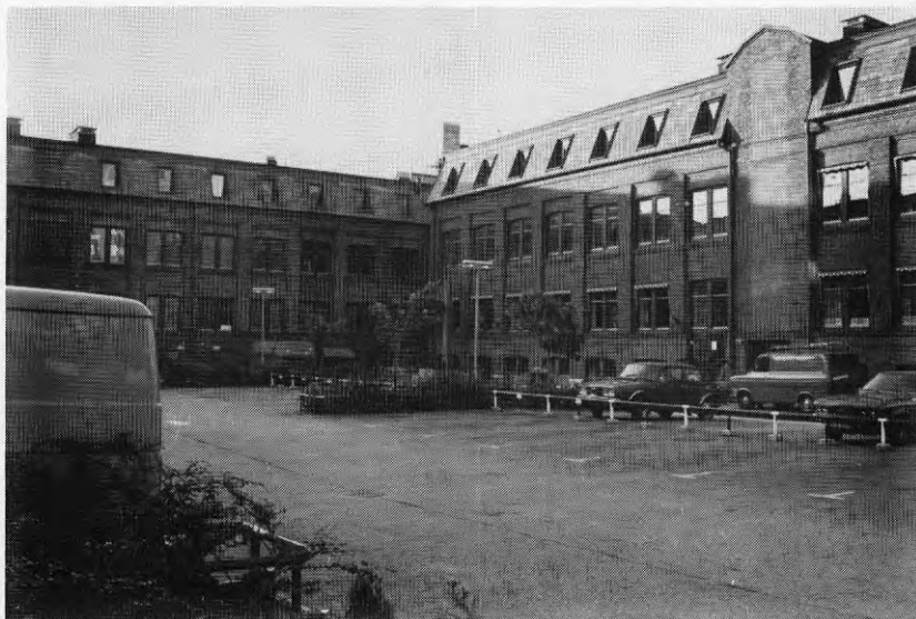
Fig. 5.3 Det är värdefullt med parkeringsmöjligheter på rymlig gård. Industrihuset Eden, Malmö.
