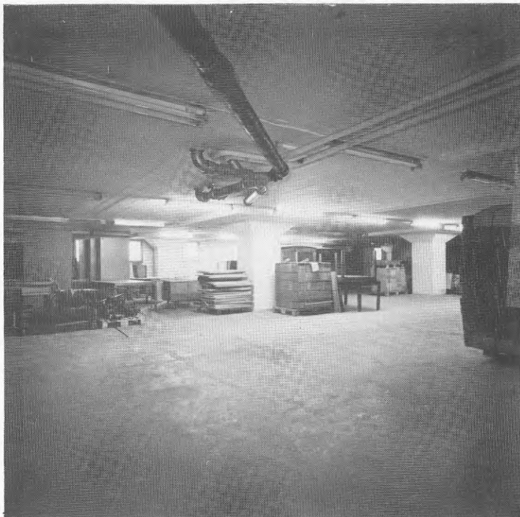
Fig. 5.11 Rumshöjd under 2,4 m begränsar kraftigt användbarheten.
