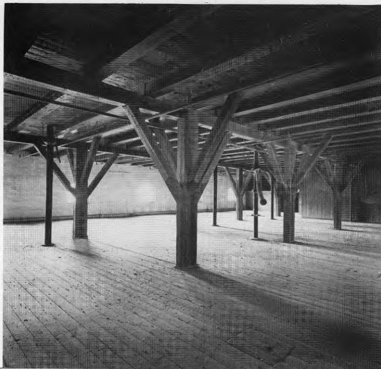
Fig. 5.10 Stomme av trä i kornbotten, Stora bryggeriet, kv Hornsberg, Stockholm.
