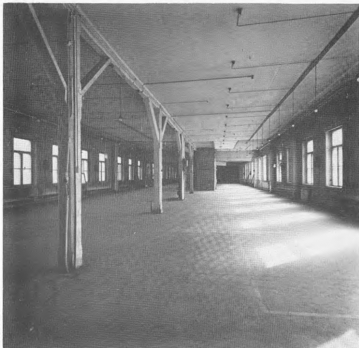
Fig. 5.7 Husdjup på 12-13 m gör lokalerna lätta att använda till kontor. Skofabriken i kv Släggan, Stockholm.
