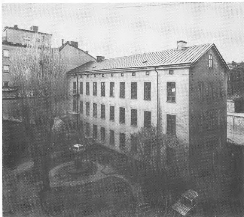
Fig. 2.5. Almgrens sidenväveri i Stockholm. Byggnaden används delvis till konstateljéer, men skall troligen bevaras som museum.
