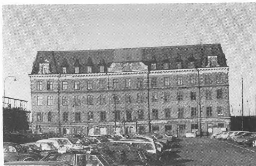
Fig. 5.18 Godsmagasin i Göteborgs hamn på lerlager av växlande tjocklek. Nivåskillnaden är 2 m mellan hörnen.
