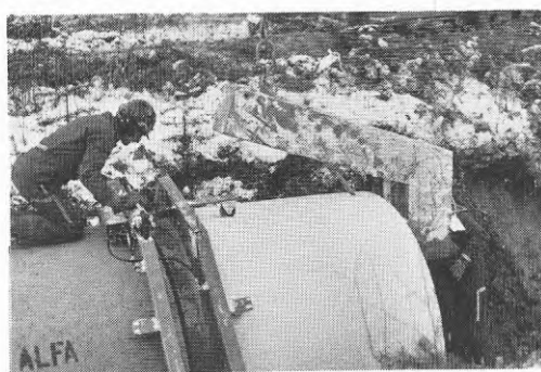
Fig 5.11 Hydraulisk hopdragare för betongrör.
