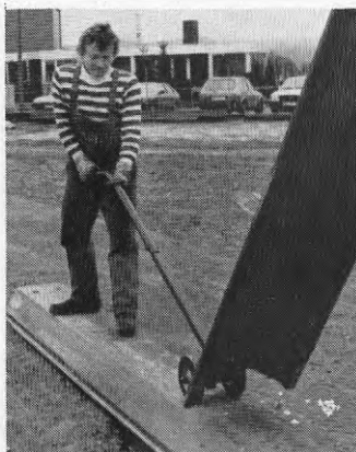
Fig 3.4.3.5. Hjälpmedel för hantering av tung spont.
