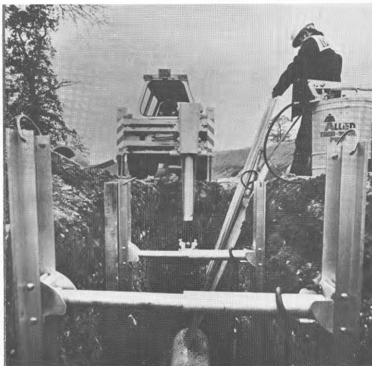
Fig 3.4.3.10. Exempel på monterat amerikanskt vertikalt lättmetallsystem, Allied Tren-Shore.
