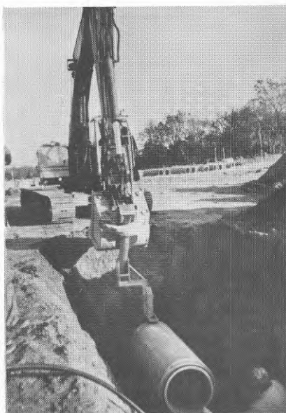
Fig 5.2. GRAB-JOHN med rörgrab som fungerar både som lyftredskap och som läggningsverktyg.
