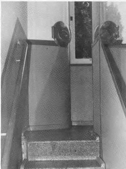
Figur 8 Bild av det färdiga hissshacket.
