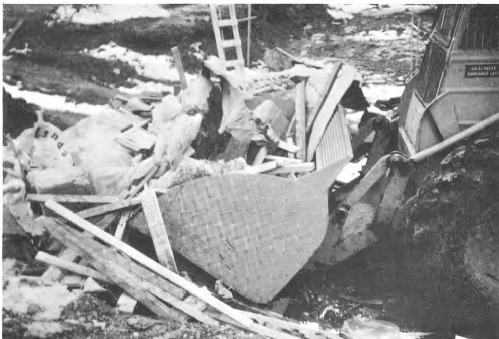
FIG. 4.4.6 Användning av traktor med skopa vid avfallshandling.
