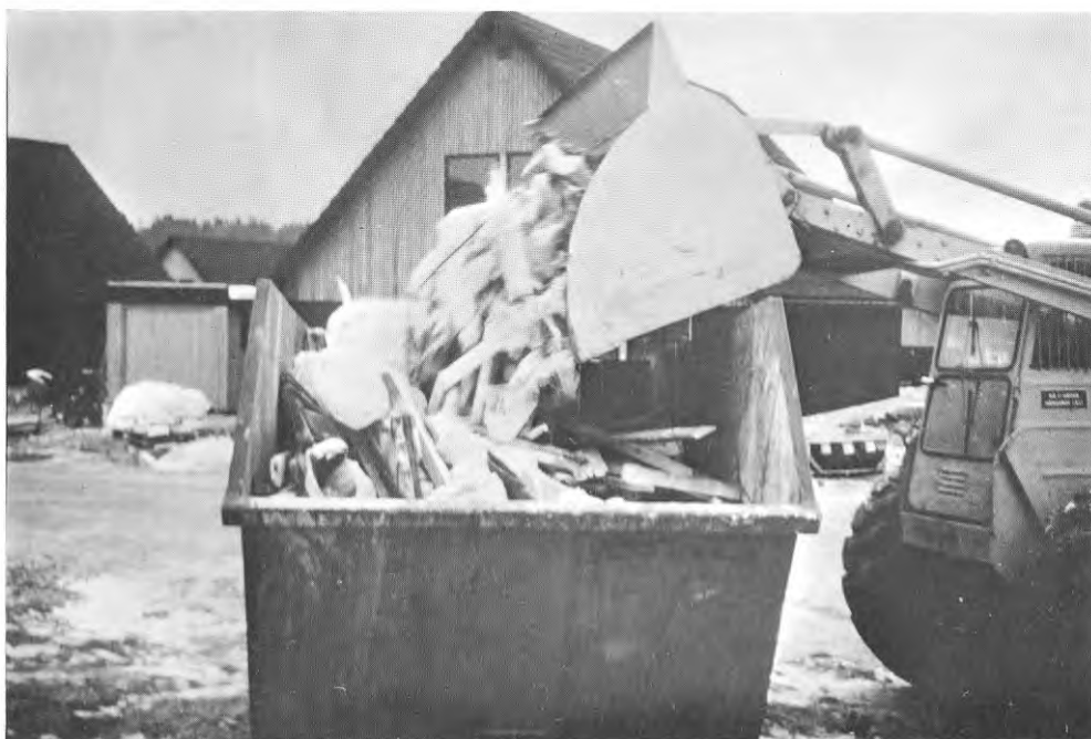
FIG. 4.4.7 Användning av traktor med skopa vid lastning av container.
