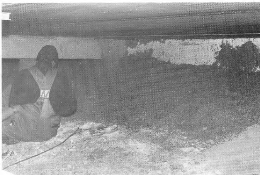
17 Sprutning på kryprummets botten ca 1 m in från sockeln med mineralull och lim till en tjocklek av ca 10 cm.
