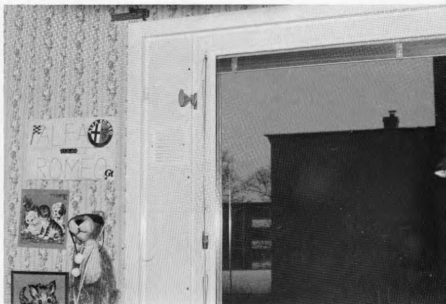
26 På vådringsbågens plats görs igenfyllning med isolermaterial och insätts tilluftsventil.
