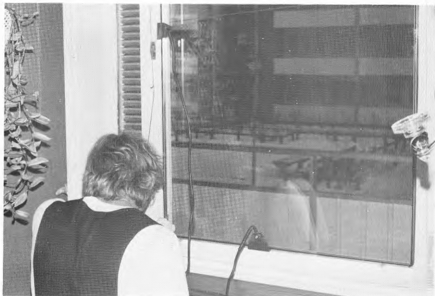
24 Uppvärmning av butylmassan efter det att 3dje rutan pressats in.
