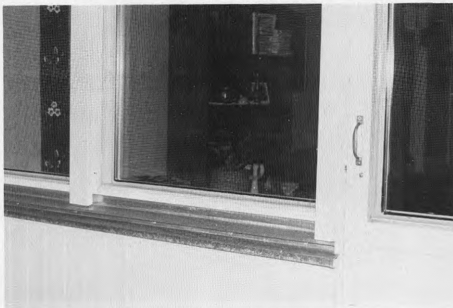
21 2-glas träfönster, sett från utsidan.
