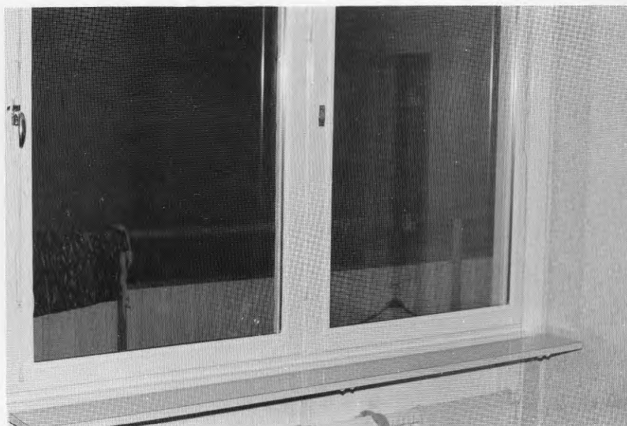
22 2-glas träfönster, sett från insidan.
