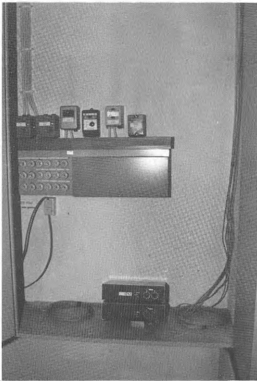
Mätare i trapphusförråd för temperaturmätning.
