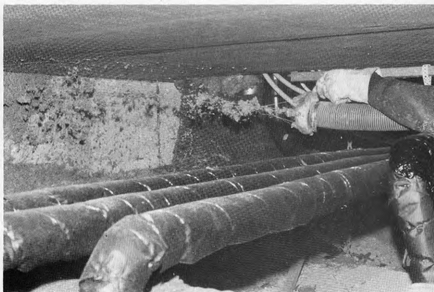
19 Sprutning av vägg bland hindrande rörledningar.
