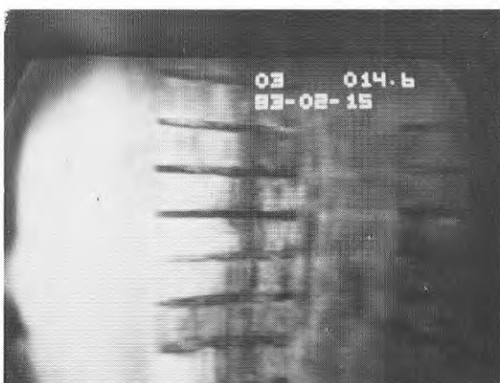
Figur 7.2. Järnutfällningar i filterbrunnar. Bilderna är tagna med undervattenskamera. a) och b) visar utfällningar i och utanför slitsarna i ett rostfritt filterrör, typ "Johnsson screen". c) visar utfällningar i slitsarna på ett träfilterrör, typ "OBO".
