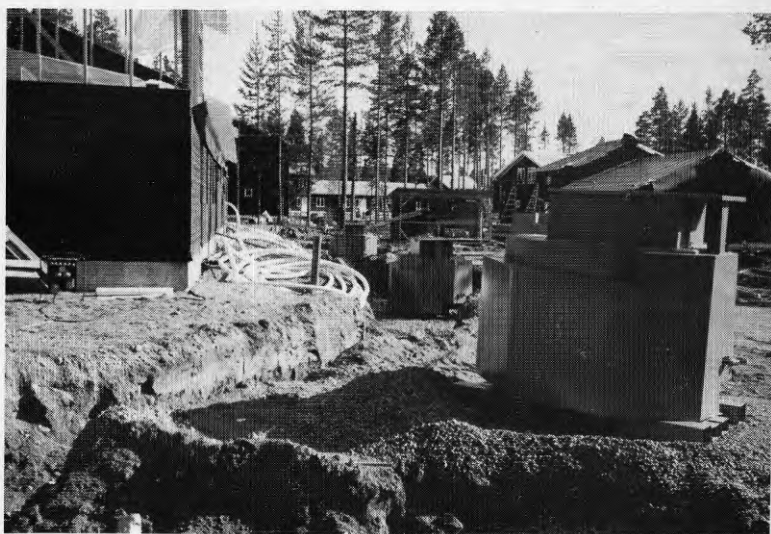
FOTO 3 : Jordvärmeugnarna under montering. Ugnarna placeras på ett dräneringslager av singel med nedstigningsluckan i markhöjd.
