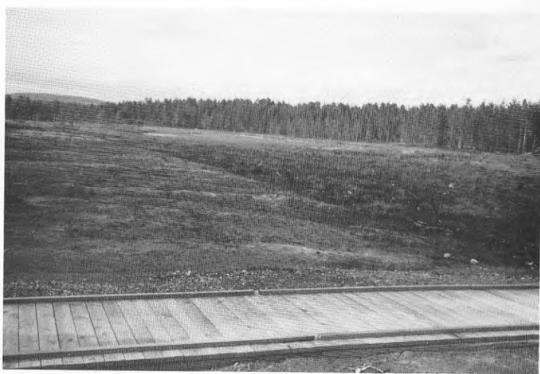
FOTO 2 : Myrlott A efter färdigställande där ytan avjäm- nats med sand. Plastslangarna har samlats i en gjuten samlingsbrunn som här syns med avtagbara trälock.
