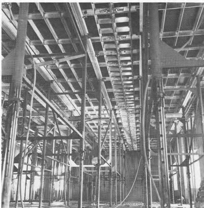
Fig 6.3 Formsystem för gjutning av takbjälklag
