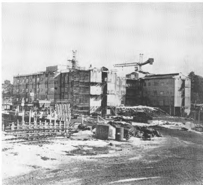
Fig 6.1 Nybyggnad av betongstomme för länssjukhuset i Norrköping. Bilden tagen 1 mars 1984.
