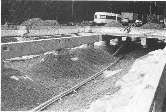
Figur 4.20 Pågående grundläggning för försöksbarnstugan .
