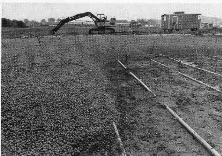
Figur 6.10 Kopplingsledningar ovanpå lagret i skiktet av leca-kulor.
