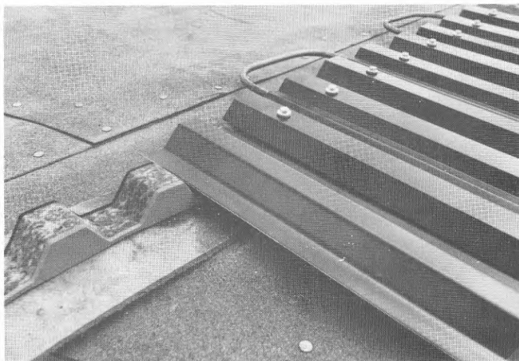
Figur 6.2 Närbild av solfångare (stripes med kopparrör, TRP-plåt)
