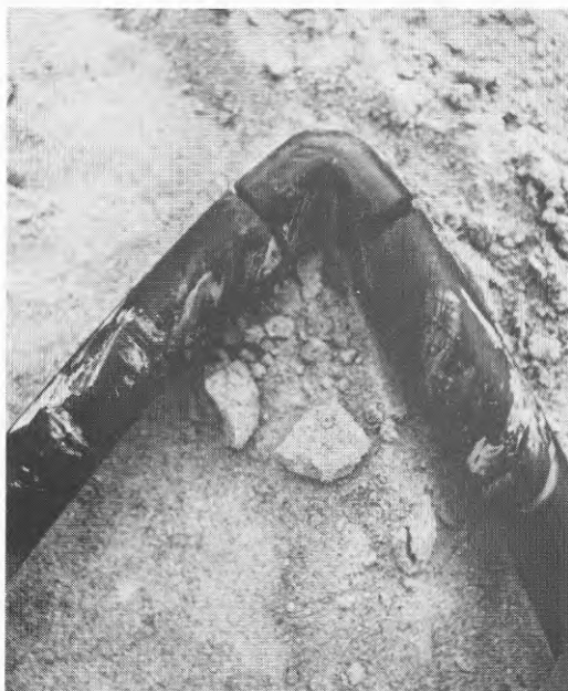
Figur 6.5 Nedre delen av "U-röret"
