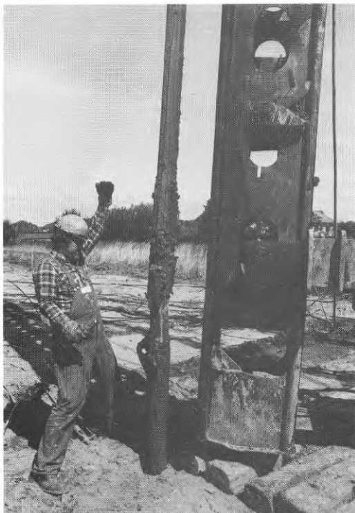
Figur 6.6 Nertryckning av ihålig påle
