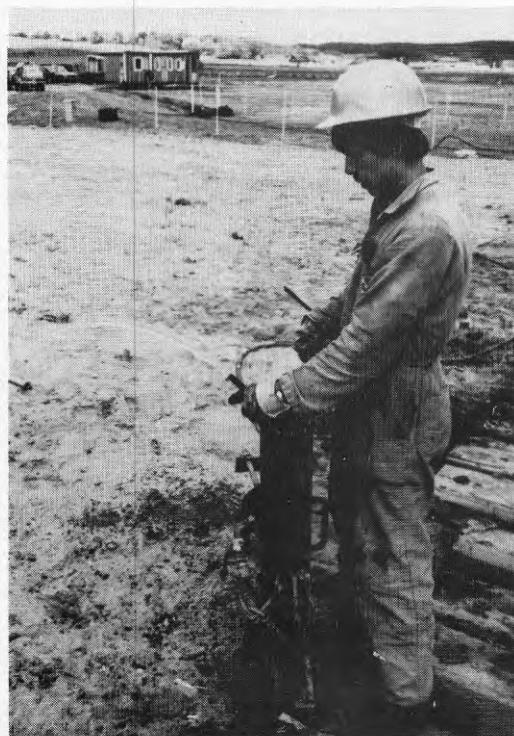
Figur 6.8 Plaströret vattenfylles
