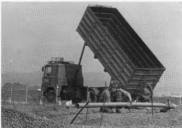
Figur 6.9 Leca-kulor sprutas över ackumulatorn som isolering och dränering.
