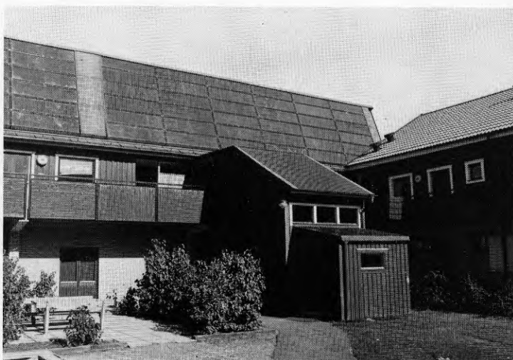
Bild 2.4 Detalj från B-huset med loftgång och trapphus till bostäderna.
