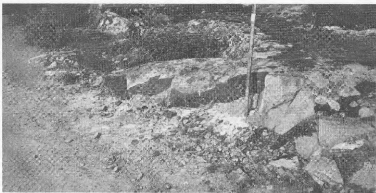
Fig. 4.1a,b,c. Utskjutande bergkant i väg som spräckts bort. Snett inborrat hål i bergkantens framsida, upphettas med gasspräckare c:a 1 timme, därefter avlyft med patronspräckare; begynnande uppbyggnad av bergkanten.
