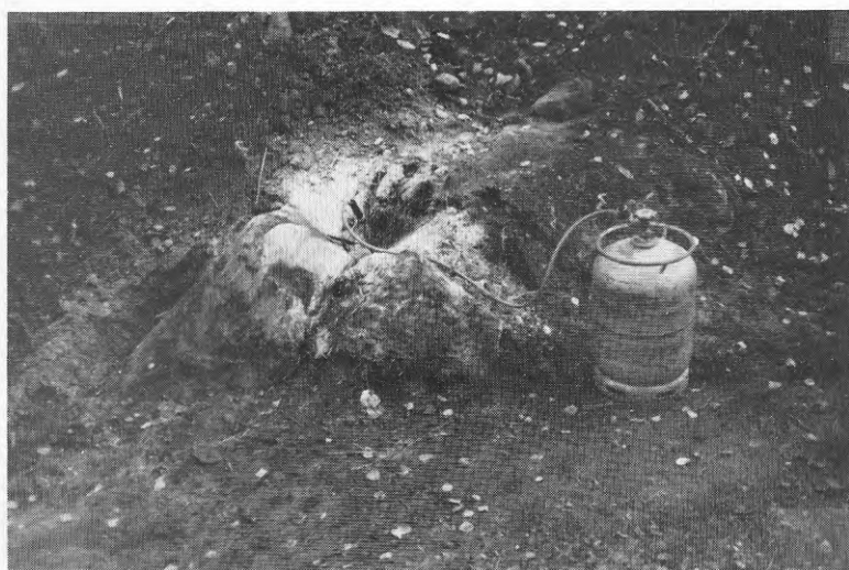
Fig. 4.4 a,b,c. Fotografierna visar faser i borttagning av dikessten. Patronspräckaren har avfyrats och vidgat mm-sprickorna till cm-sprickor, dvs. lossgjort en del av bundet berg.
