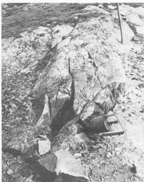
Fig. 4.1a,b,c. Utskjutande bergkant i väg som spräckts bort. Snett inborrat hål i bergkantens framsida, upphettas med gasspräckare c:a 1 timme, därefter avlyft med patronspräckare; begynnande uppbyggnad av bergkanten.
