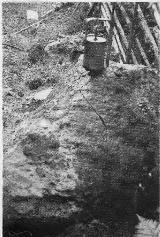
Fig. 4.5.a,b. Större sten vid väg förspräcks med gasspräckare, och patronspräckaren har där- efter placerats i borrhålet.
