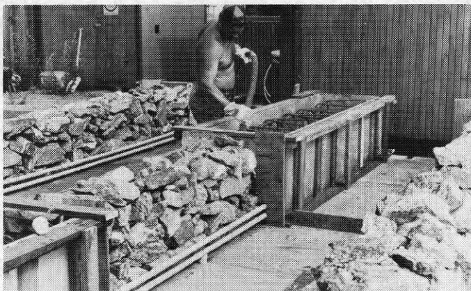
Bild 4. Platsgjutna ändbalkar inom kallmursbalkens skjuv- område, balk B2.
