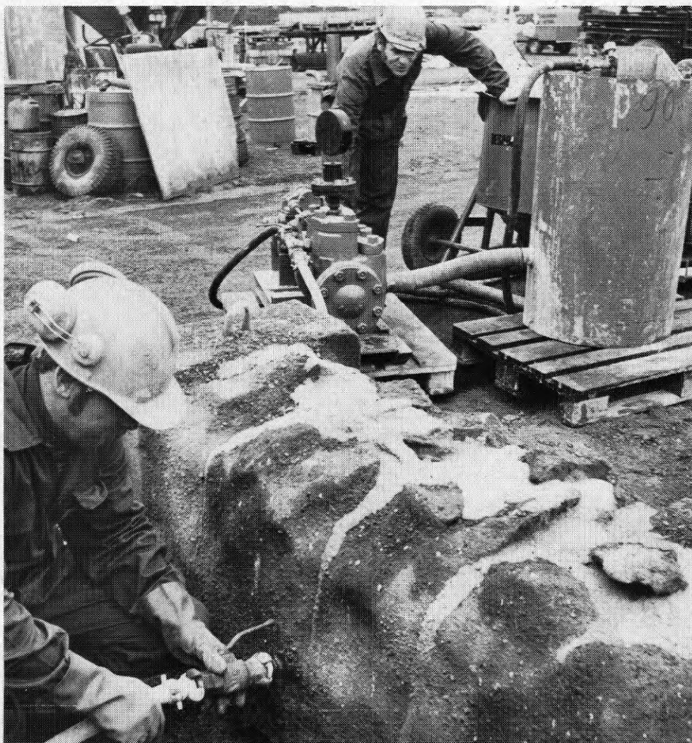
Bild 5. Nedan. Injektering av kallmur.
