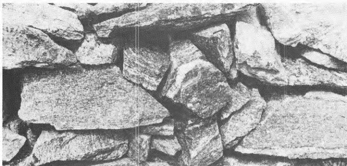
Bild 1. Detalj av sprängstensmassans struktur i kallmuren.
