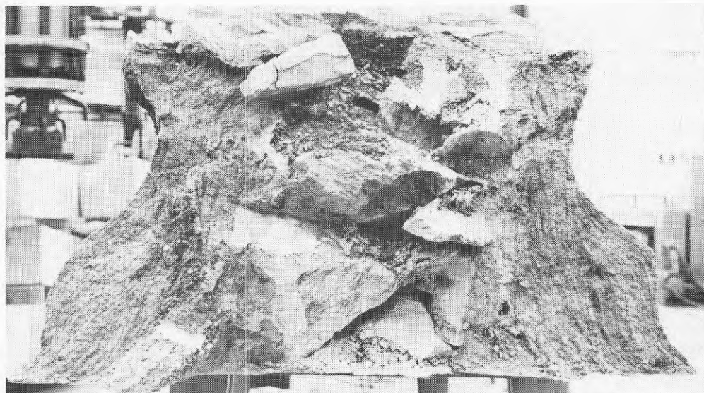
Bild B5:2 Tvärsnitt av brottstället. I bildens centrala delar syns hålligheter i balken under stenarna, vidare syns en del fibrer som sprutats långt in mot balkmitt vid påsprutningen av den utvändiga fiberbetongen. Man ser också det injekterade bruket liksom brottställe mellan stenar och kvarvarande bruk. På balkens båda sidor syns fiberbetongen som pålagts i flers lager.
