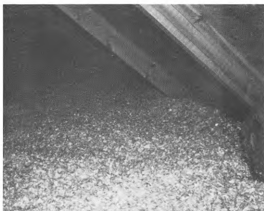
c) Fotografi av takbjälklagets isolering efter tilläggsisolering.
