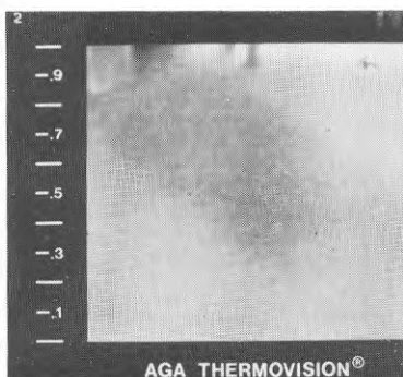
c) Termogram av ytparti vid golv. Här framträder en nedkyld zon på golvet. Nedkylningen har samband med luftinläckning i bjälklaget.
