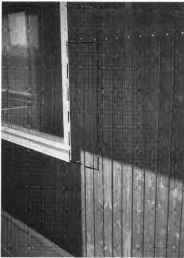
b) Solbelysning på fasaden kl 15.00. Ytparti med reducerad isolering har markerats.
