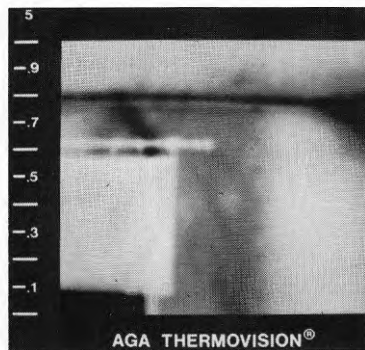
c) Termogram av nedkyldt väggparti. Det nedkylda väggpartiet hade en vertikal utbredning från golv till tak.
