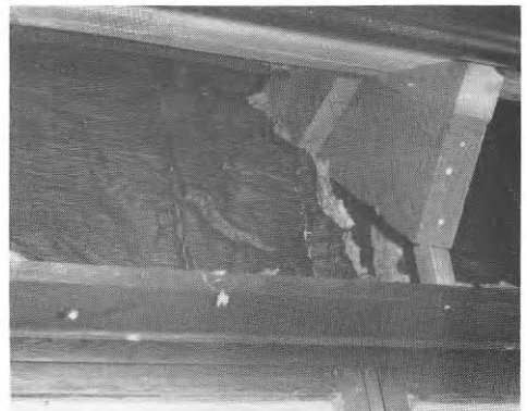
b) Skiss av iakttagen feltyp: Avsaknad av vindskydd vid takfot samt dålig anpassning av mineralullsisolering mot takstolar och hammarband.
