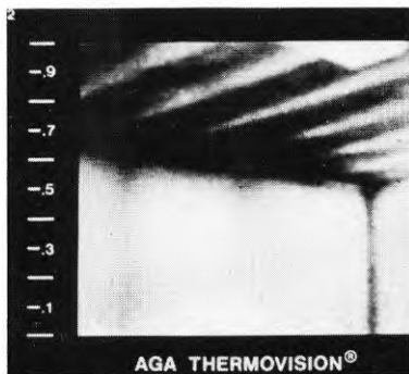
c) Termogram av ytparti vid takvinkel. Nedkylda ytpartier i tak framträder som väl markerade mörka ränder.
