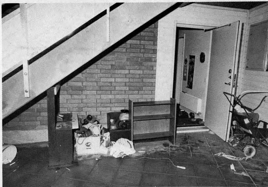
(R3) Egen ingång uppskattas. Här kan barnen få en egen lekvrå under trappan till lägenheten ovanför.
