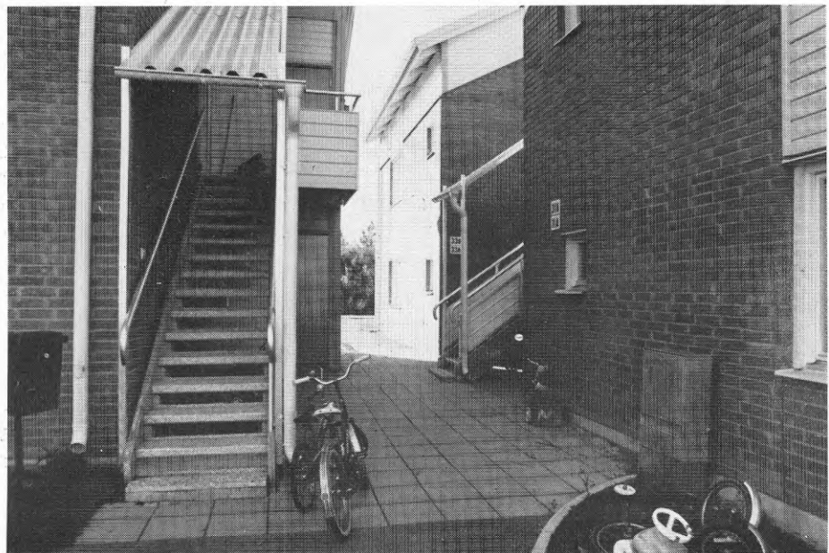
Lägenheterna, på övervåningen nås via en trappa utomhus.
