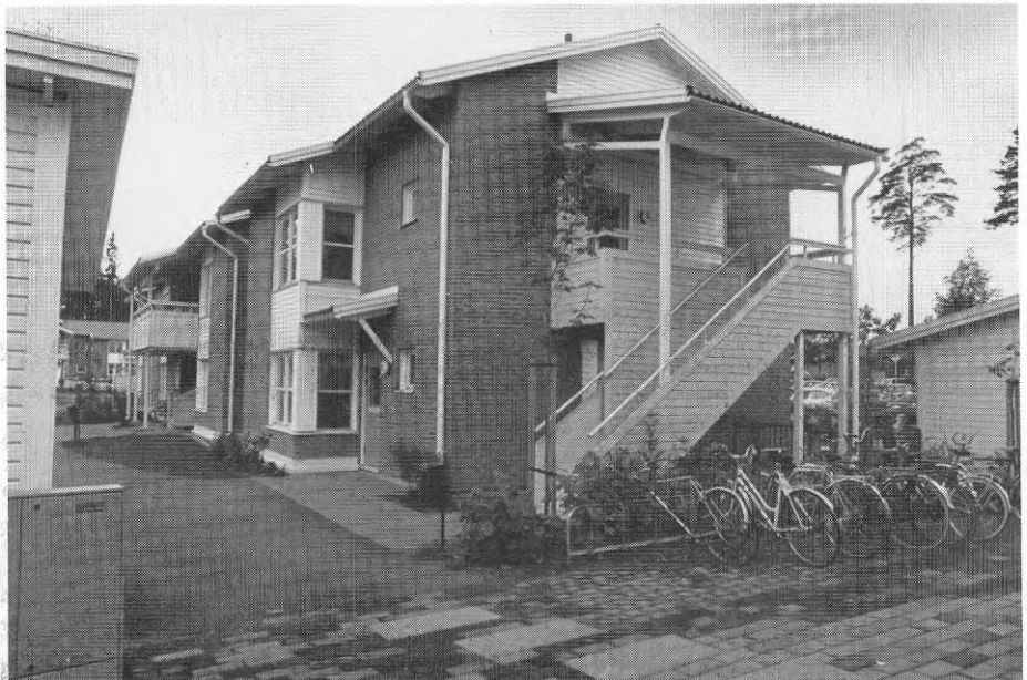
Kv Renblomman. Det är trångt mellan husen på många ställen i kvarteret.
