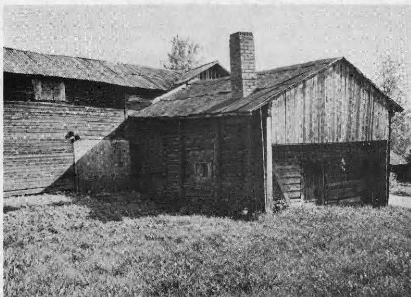
Äldre fähus av timmer. Taket kragar ut över ena gaveln varigenom ett fähuslida bildas. Entré sker från detta lida.
