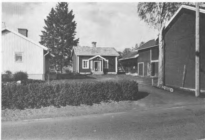
Exempel på "kvadratisk" gårdsbildning. Bostadshuset t. v. är nybyggt och har ersatt en äldre uthuslänga (Trogens gård).
