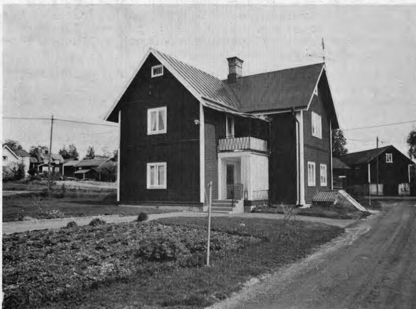
"Sekelskifteshusen" är ofta högre än de äldre morastu- gorna. De har brantare takvinkel och är ofta byggda i vinkel ("Bossels" gård).
