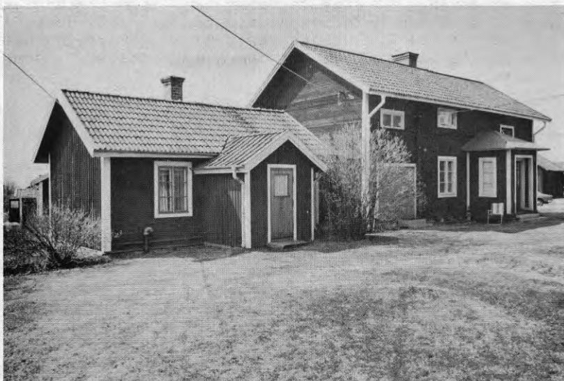
Byggnadernas proportioner är en faktor som har särskild betydelse - t ex höjd/bredd, takvinkel, taksprång etc (Holmers gård).
