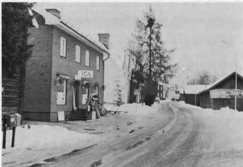
Samma byggnad 1976. Affären har försetts med källare och spiktegel, varvid byggnadens karaktär försvunnit.
