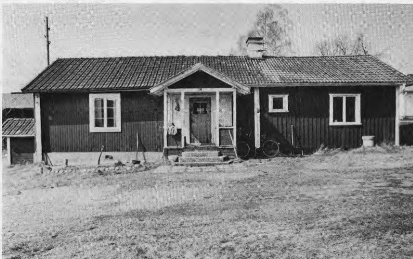
Parstuga - dessa är inte vanliga i Färnäs och de som finns är ofta påbyggda morastugor (Olmåsgården).
