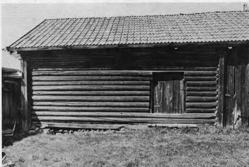
Mindre timmerlada med entré från långsidan.
