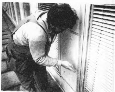
Figur 6.1f Fogmassan trycks till och fogytan glättas med fogpinne (11).
