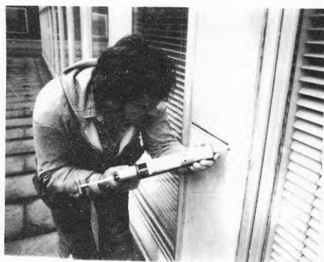
Figur 6.1e Fogmassan appliceras med spruta till den profil som föreskrivs för fogmassan.
