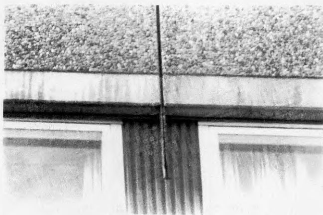
Figur 9.2 Fogningslisten har glidit ur fogen. Felaktig listdimension i förhållande till fogbredd har använts
