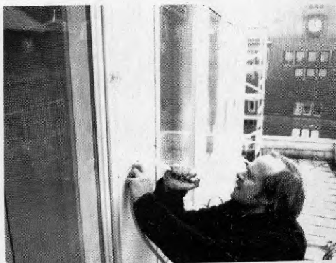
Figur 6.1b Bottningslist monteras så att rätt fogdjup erhålls.
