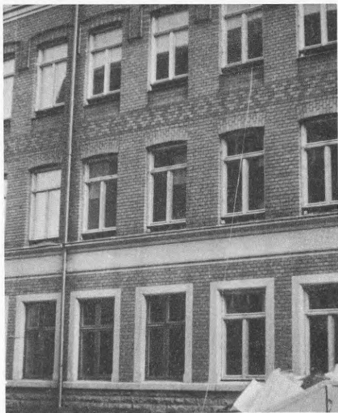
FIG.12 Fyrlufts-fönster byts ut mot trelufts-fönster med T-post. De nya fönsterna är mindre än de gamla och placeras i ovankant på fönsterhålet.
