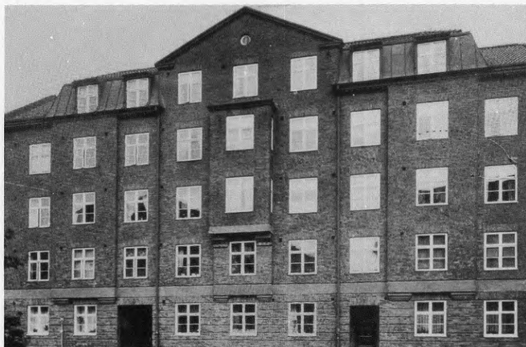
Fasad C. Byggnadsår 1927.
