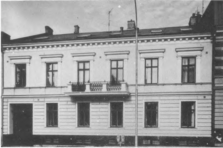
Fasad A. Byggnadsår 1888.
