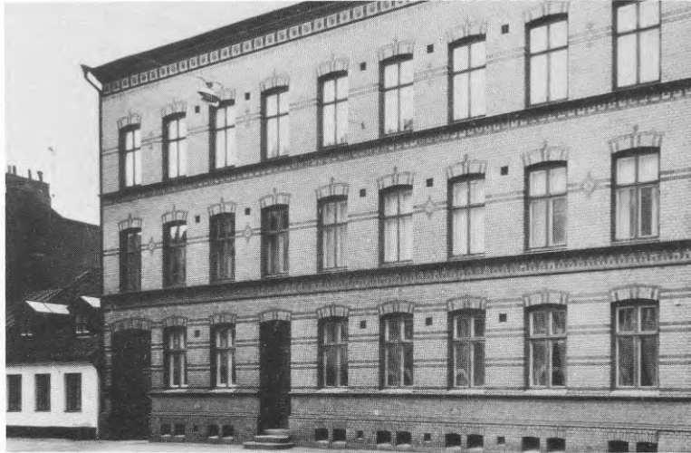
Fasad B. Byggnadsår 1903.
