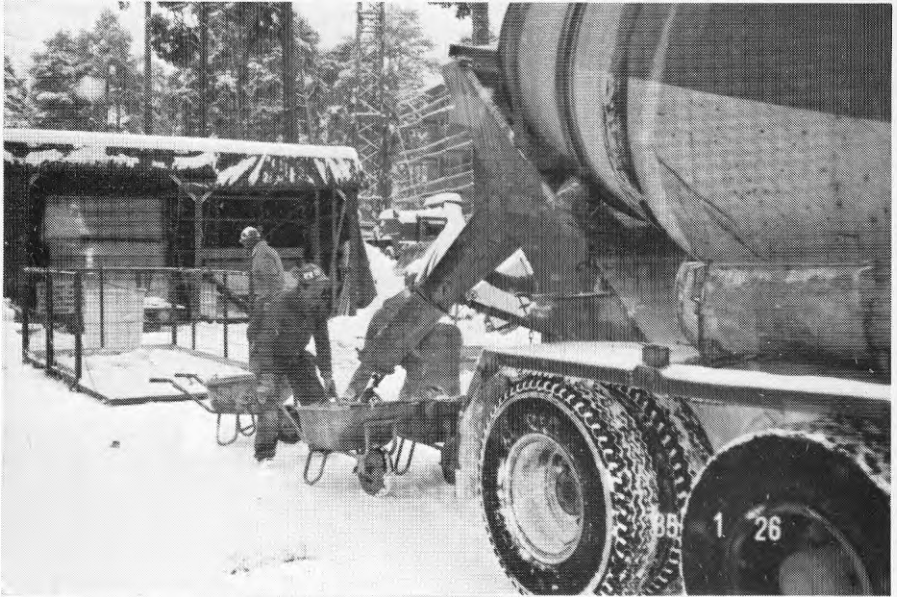
Fig 1. Manuell hantering av fabriksbetong.
