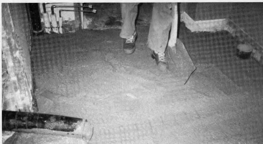
Fig 9. Gjutning av badrumsgolv med hjälp av ROT-pump. Observera slangen genom vilken betongen strömmar.
