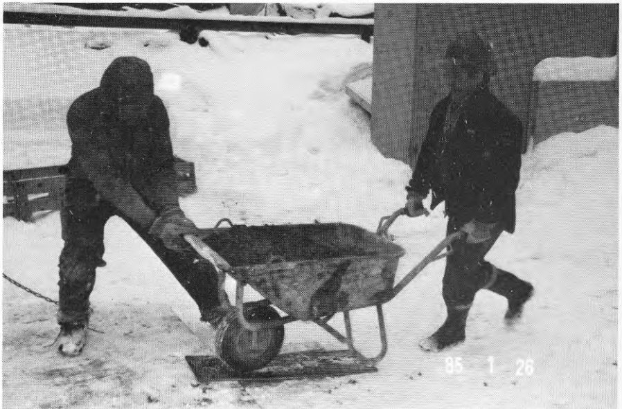
Fig 2. Situationsbild från kärning av betong under vinterförhållanden.
