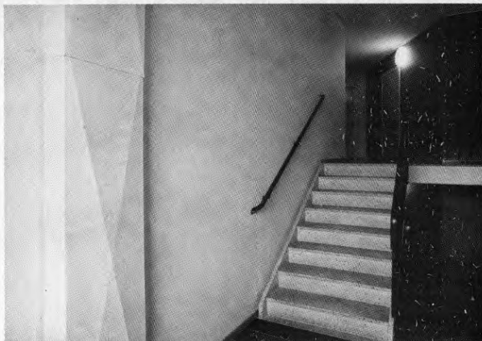
Inklädd dragning av värmebärarrör i trapphus
