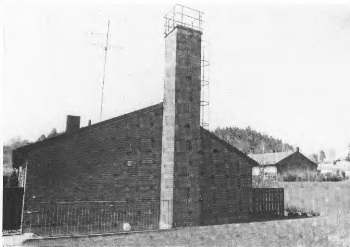
Figur 2.1. Panncentralen i kvarteret Dromedaren, Kinna.
