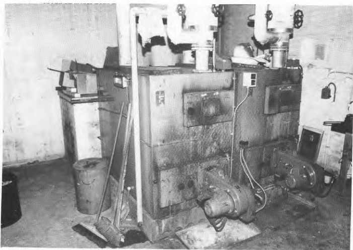
Figur 2.2. Pannorna före installation av rök-gaskylare.
