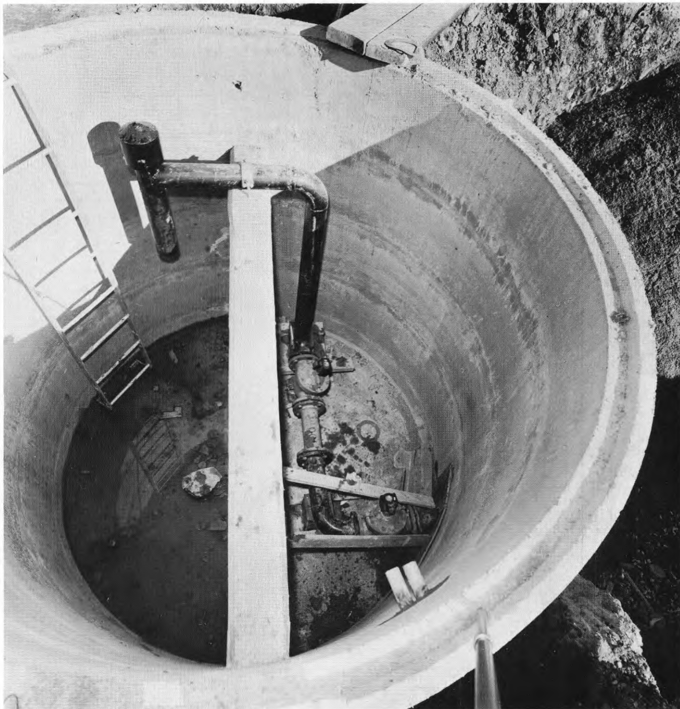
FIG 28. Nivåregleringsbrunn. I den vänstra kammaren regleras vattennivån med nivåvippor. Påfyllnadsrör i botten.
