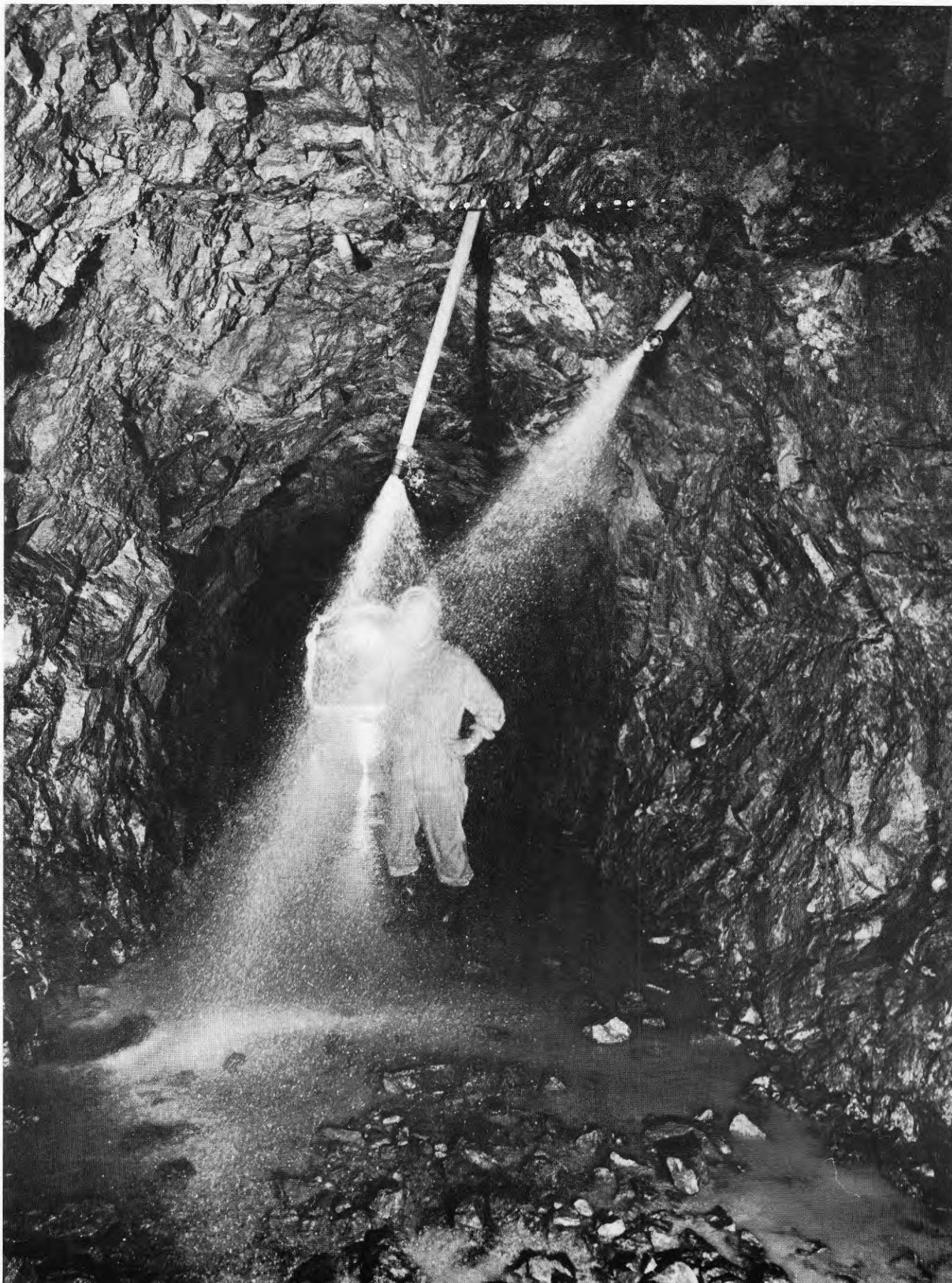
FIG 30. Infiltrationshål i solfjädersform försedda med back-ventiler. Tunneln vattenfylls genom att öppna ventilerna.
