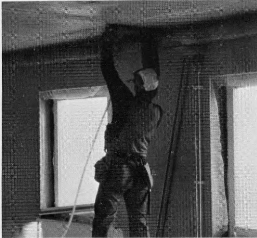
Bild 3. Montering av skenor och reglar, med bultpistol.
