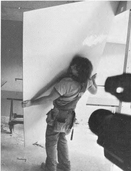
Bild 7. Uppvridning av 1200 mm skiva mot regelstomme. Armarna låsta av format och tyngd, arbetet sker med ryggen.
