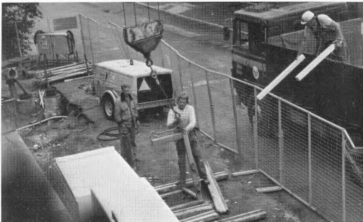
Bild 2. Intransport av gipsskivor med tegelgaffel på Långsjötorg.
