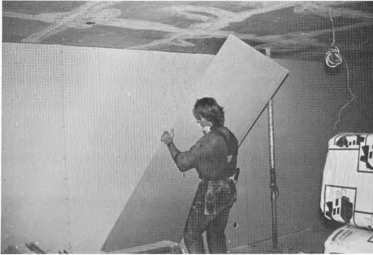
Bild 6. Uppställning av 900 mm skiva mot regelstomme. Arbetet sker helt och hållet med armarna.
