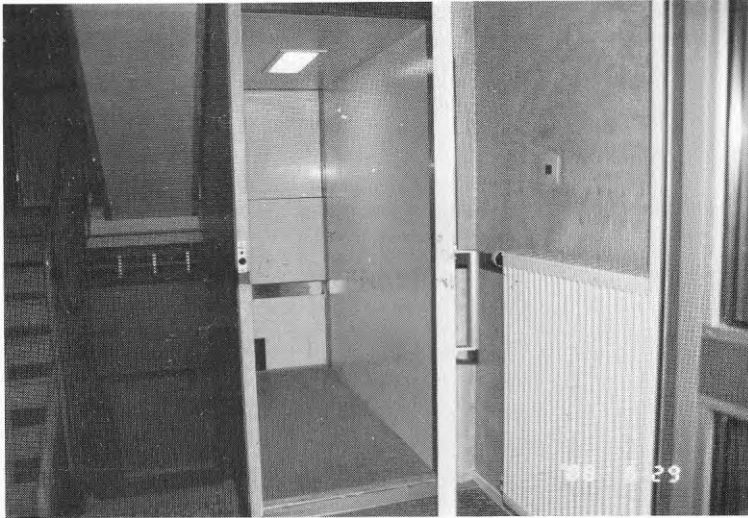
Figur 5.2 Sidoplacerad smalhiss från C.E. Söderlunds Hiss AB. Utformningen av detaljer på räcken, entréer etc. är viktig för god funktion.
