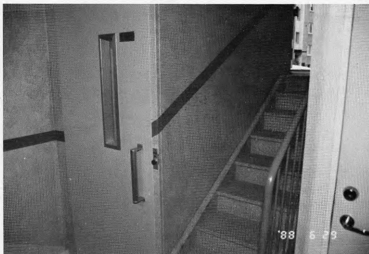
Figur 5.5 Schaktets väggar kan levereras färdigmålade eller som här bekläds och målas lika som trapphuset.
