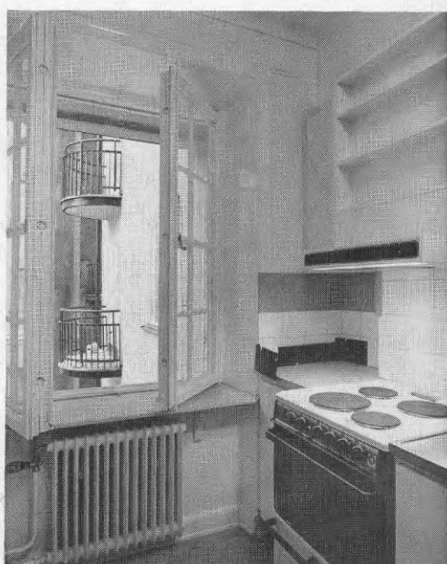
Radiatorerna demonterades och rensplades samt försågs med nya termostatventiler. -Här är spiskåpan monterad.
