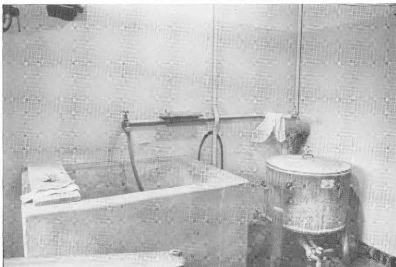
Figur 4.15 Tvättstugan på vinden har en gammal tvättgryta och ett stort betongkar för blötläggning och sköljning.
