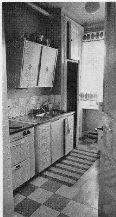
Figur 4.8 Kök med nyare diskbänk. Obs skafferiets mjuka anslutning till taket.
