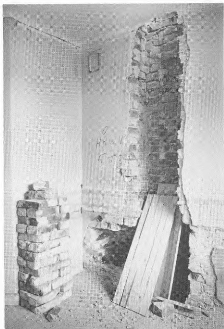
Figur 6.15 Frånluftsdon i kök (Bild från ombyggnadstiden)
