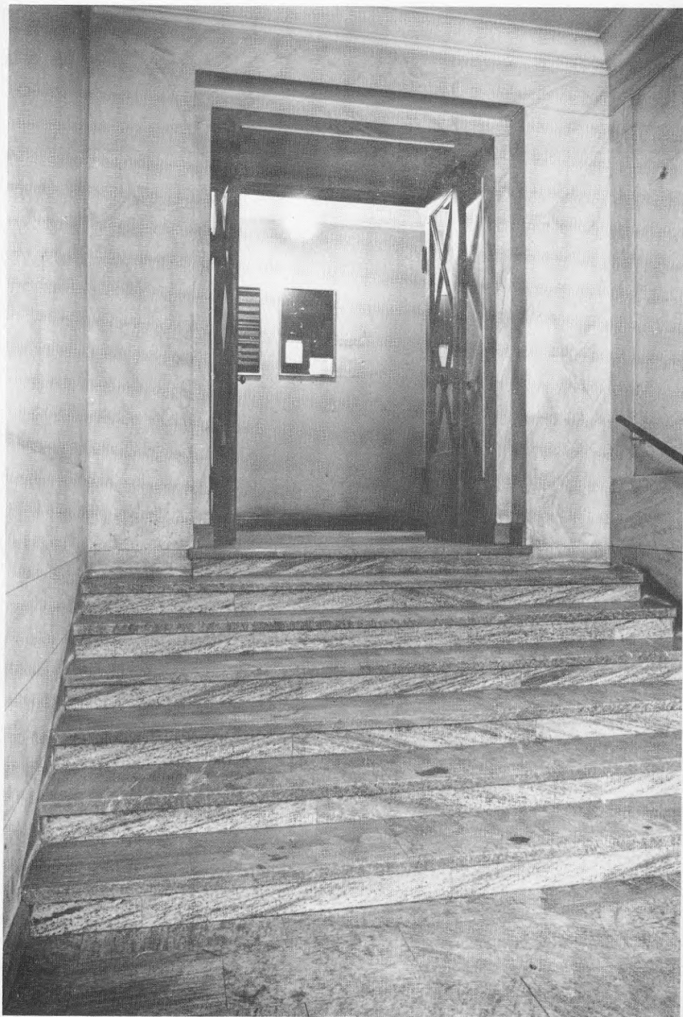
Hvudentrén - gatuentrén - till fastigheten Loket 8, Stockholm; före ombyggnaden
