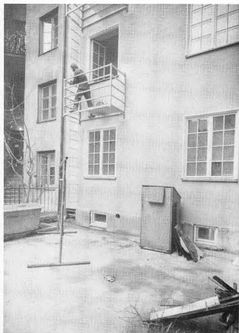
Nya brandbalkonger med stegar monterades utanför fönstren i gathusets souterrängplan.
