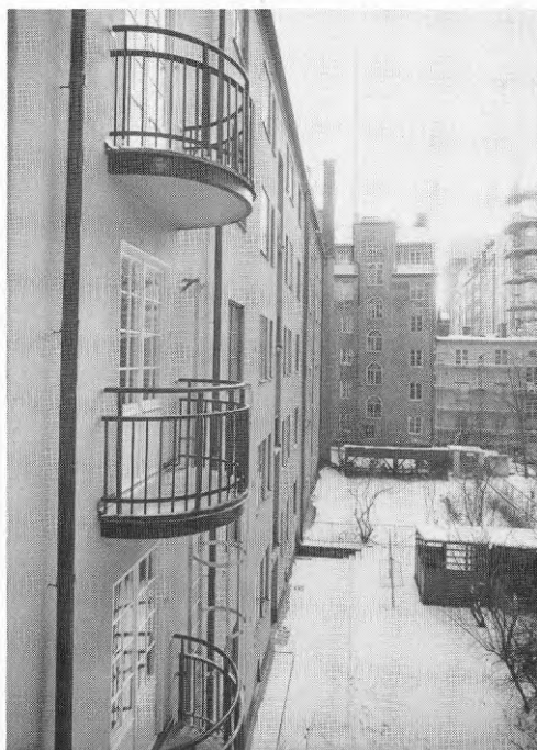
Med ny stega vid sidan av kunden de gamla, nedre balkongerna i gårdshuset utnyttjas som brandutrymningsväg.
