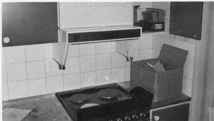
Figur 6.20 Spiskåpa med fläkt
