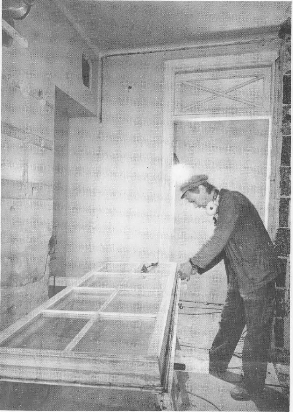
DEL I behandlar program- och projekteringsskedet. Det är då det gäller att förutse vad olika åtgärder kan innebära, både för genomförandet och för slutresultatet
