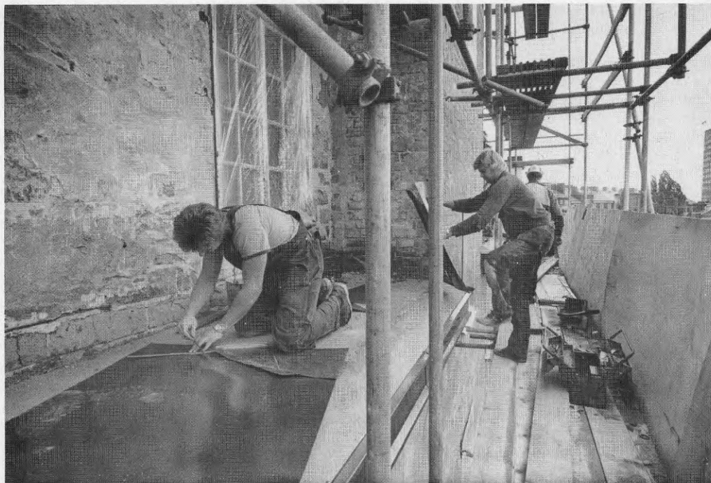
Den lösa slätputsen på gårdsfasaden knäckades ned och ersattes med ny. Plåttäckningen på tak och vid altaner förnyades.
