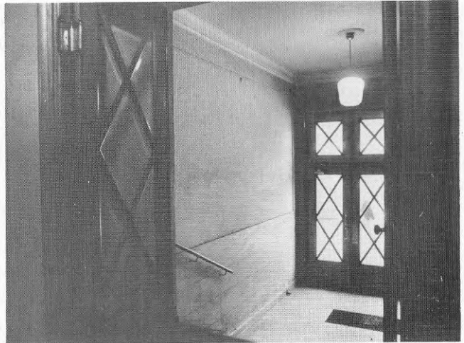
Figur 4.18 Entrétrappan och porten
