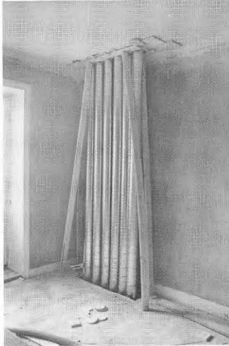
Nya ventilationskanaler från solariet 1 tr ned planerades och förlades i garderob/klädskammare. På våningen 2 tr måste dock en sidförskjutning göras, som i planeringsskedet inte samordnades med inredningen (jfr figur 4.3 i DEL I).
