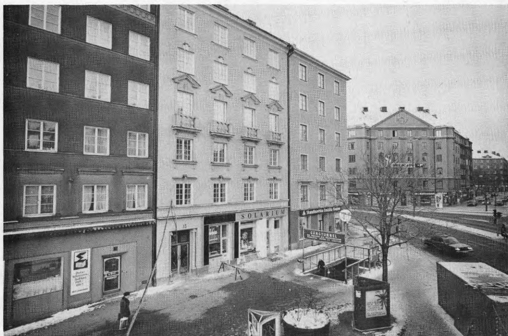
Gatufasaden fick ny slanning och alla dekorationer lagades och renoverades varsamt.
