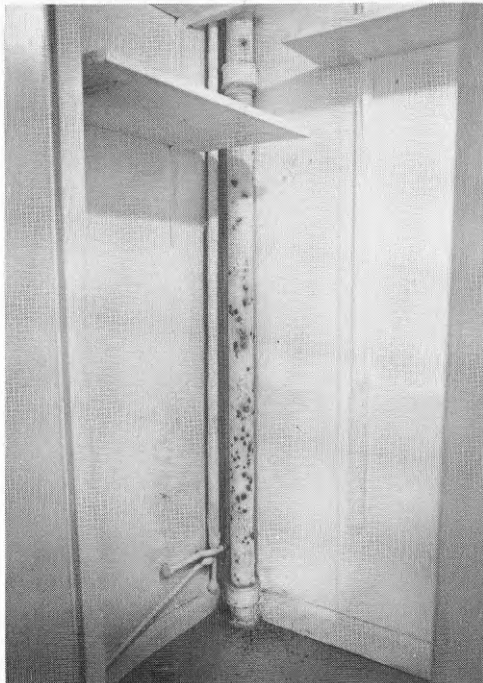
Skadorna är synliga på flera rör.
