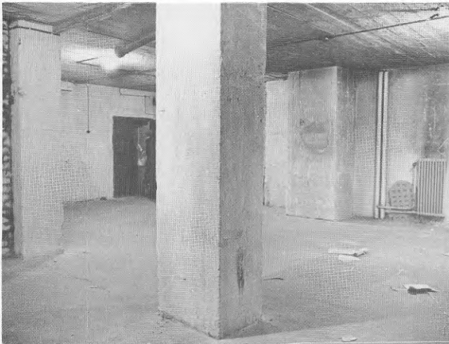
Figur 5.4 Lagerlokal under gatunivån, med dörren till varuhissens förrum t v om pelaren
