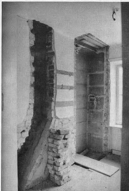
Befintliga schakt som måste utnyttjas knäckades upp och frilades.
