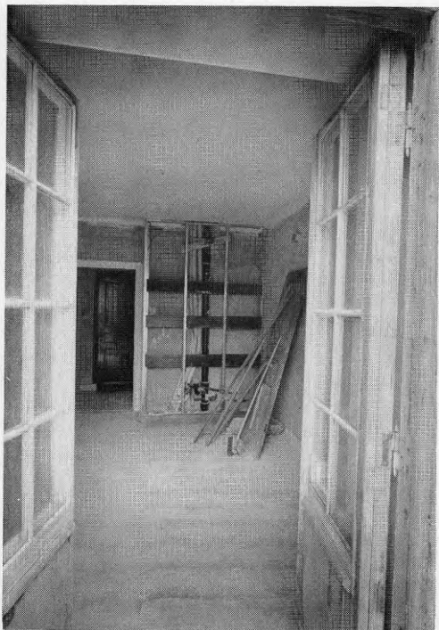
Nyinsatt avlopp i badrum, med rören förlagda i golv.
