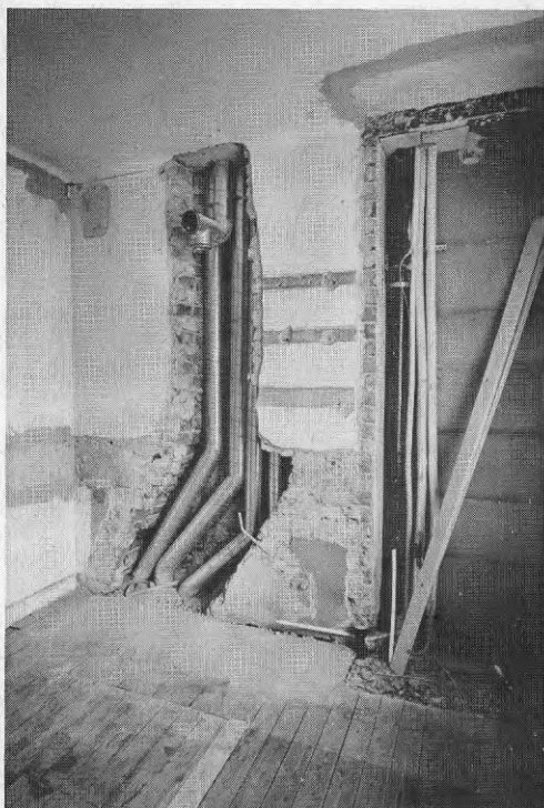
Rören kröktes och anpassades till den befintliga strukturen.
