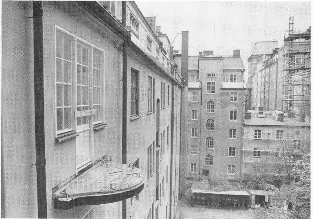
Tidstypiska 1920-talsfönster på gårdsfasaderna runt kvarteret (Loket 8 t vänster).
