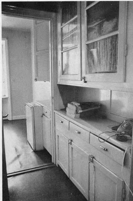
Figur 4.9 Skänkskåp i serveringsgång och kök. Hyresgästen har ersatt en del av underskåpet med ett kylskåp.
