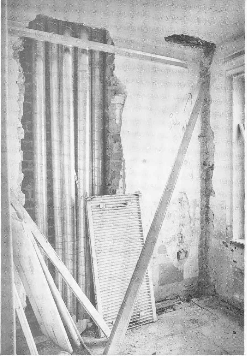
Kök under ombyggnad - en helt annan sorts arbetsplats än före och efter.
