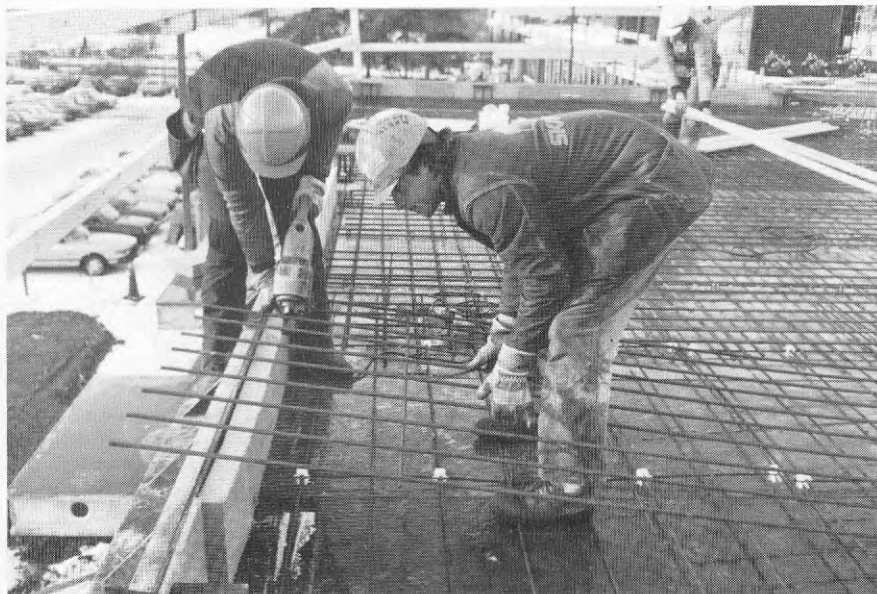
Bild 12. Kapning med kapmaskin.
