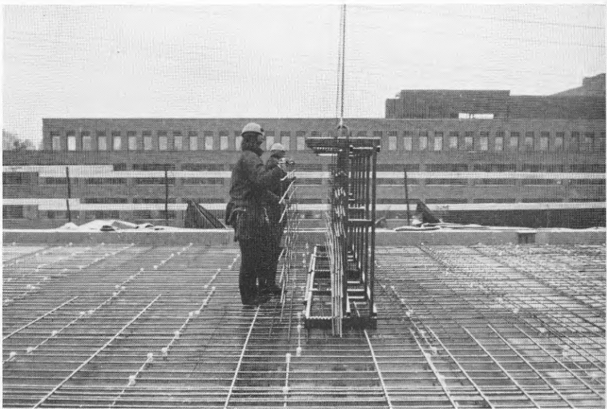
Bild 8. Nätutläggning m.h.a. ok.
