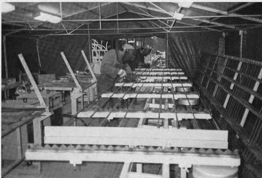
Bild 5. Inredningen i fältverkstaden. I mitten syns montagebordet, till vänster arbetsbordet och till höger skymtar transportvagnen. Bilden visar också svetsning.
