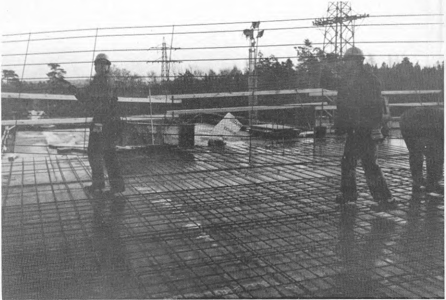
Bild 1. Exempel på utbärning av armeringsnät
