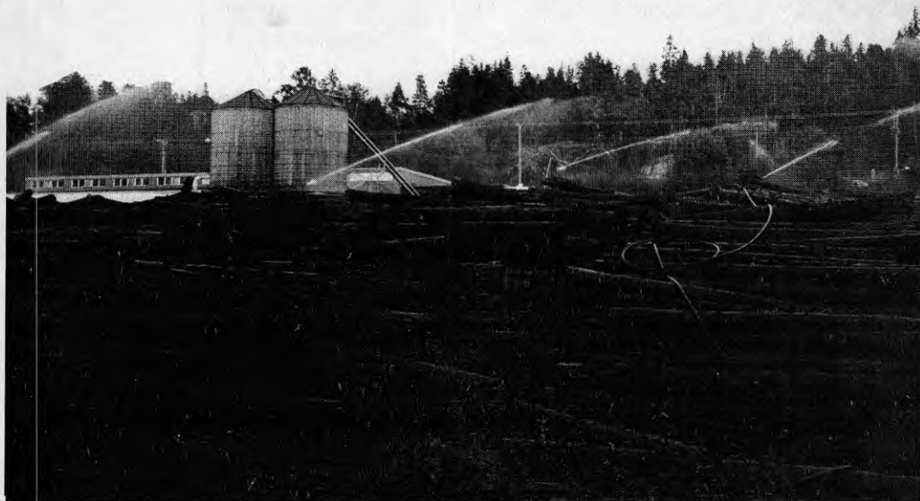
Vattenkanoner vid Sjösa såg, 2 st pumpar á 20 kW kl 07 - 17
