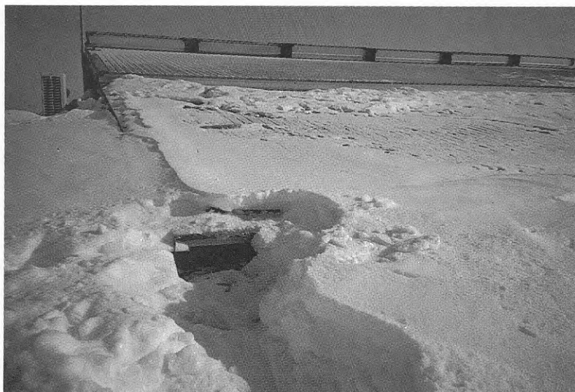
BILD 6 B Vid liten lutning och bra värmeisolering ligger snön kvar.
