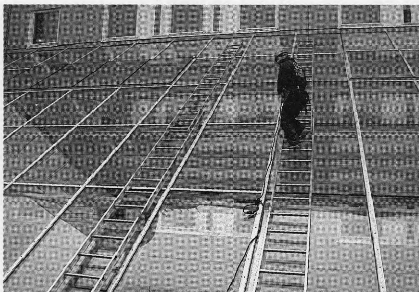
BILD 4.1 A Rengöring och service av överglasningen bör planeras i förväg.
