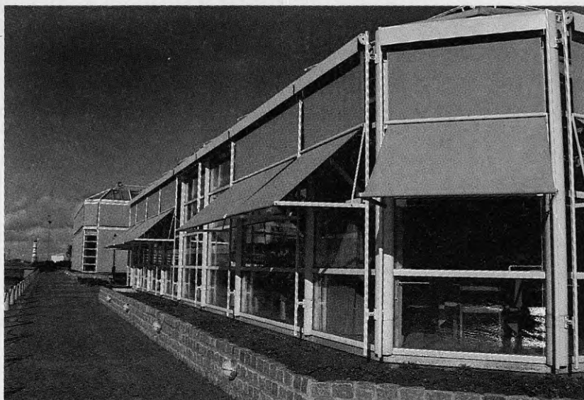
BILD 2.4 A Utvändig solavskärmning. Funktionellt rätt plats, men en dyrbar lösning som inte är helt lätt att få att fungera.
