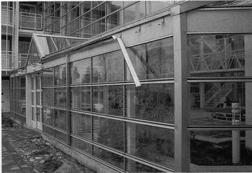
BILD 6 D Snö och is har skadat hängrännan.
