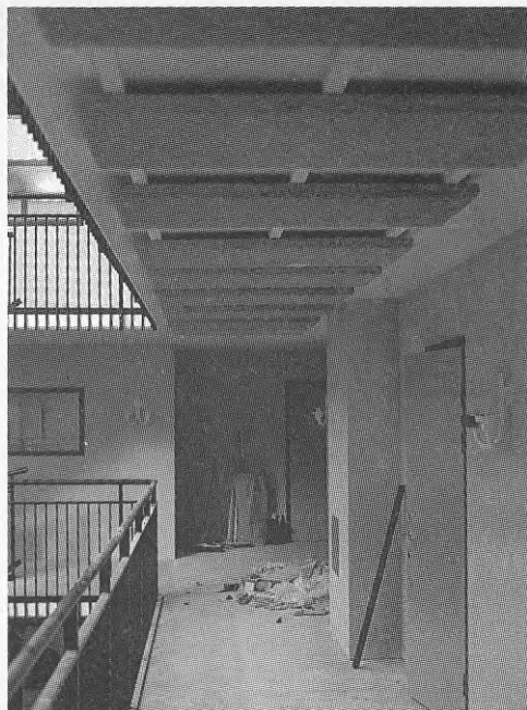
BILD 3.3 C Akustikskivor under loftgångar är bra som ljudabsorbent.
