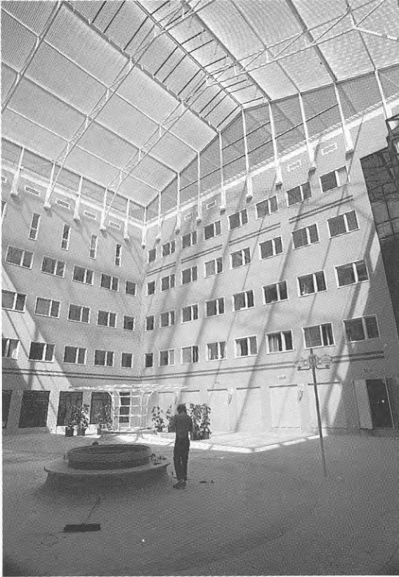
BILD 3.3 A Överglasade rum har många hårda ytor. För att få en bra akustik måste möjligheterna till akustikreglering noggrant studeras.
