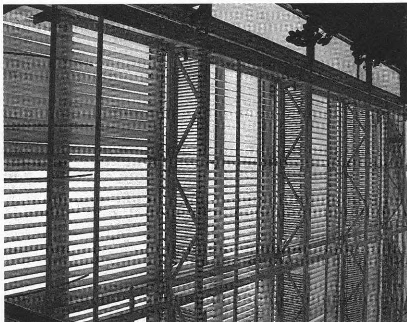
BILD 2.4 D Lameller är ett alternativ till solskyddsgardiner. Kräver bra mekanik för att fungera.
