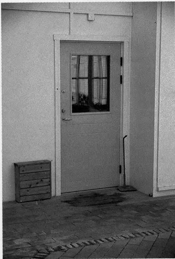
BILD 2.1 A Läckage har snarare varit regel än undantag - 2 av 3 tak har (haft) problem med läckage.
