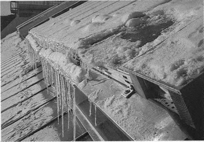
BILD 6 C Värmeläckage orsakar istappar.
