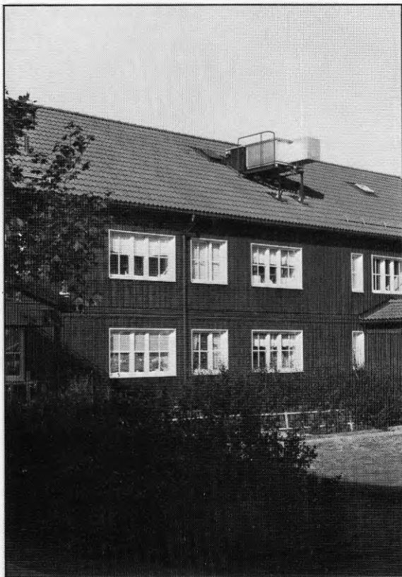
Fig 6.12 Värmepumparna på yttertaken dominerar takbilden men har inte stört hyresgästerna sedan ljudhuvarna monterats på fläktutloppet.
