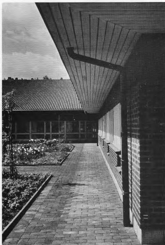
Bild 3 Byggnaden har markant utskjutande takfot
