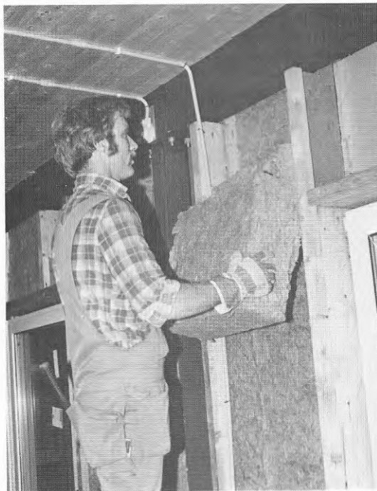
Bild 12 Husdel D är extremt välisolerad
