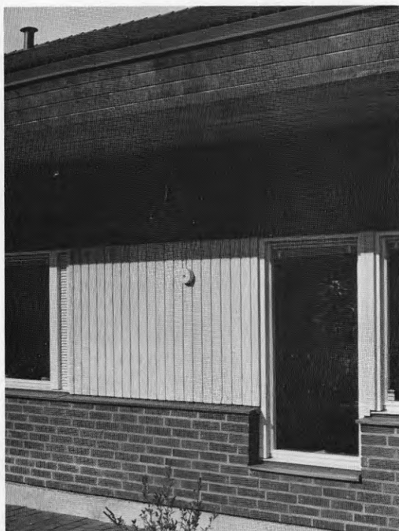
Bild 4 Utetemperaturgivaren har flyttats ned för att påverkas av solstrålningen
