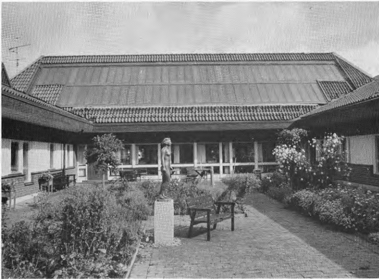
Bild 13 72 m 2 solfångare på taket till dagrumsdelen
