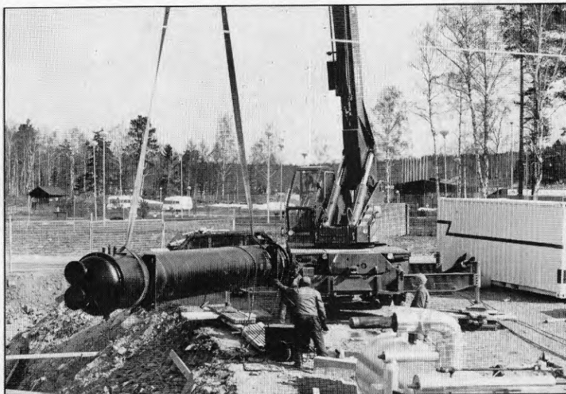
Fig 9.3 Kondensor KD2 som är "hjärtat" i hela systemet lyfts på plats i maj 1982.
