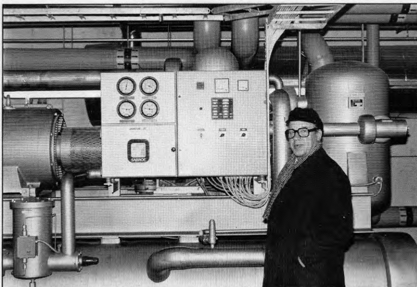
Fig 16.1 Gladast över besparingarna är kanske Bertil Österlund, kommunalråd och ordf i tekniska nämnden, som här ses framför värmepumpen i samband med slutbesiktningen.
