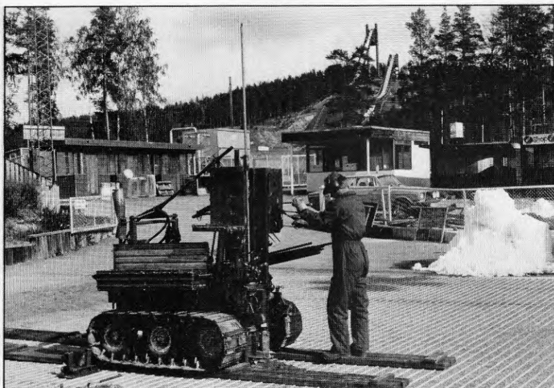
Fig.9.13 I maj -83 utfördes ett misslyckat försök att med jordborr borra hål för jordtemperaturgivarna.
