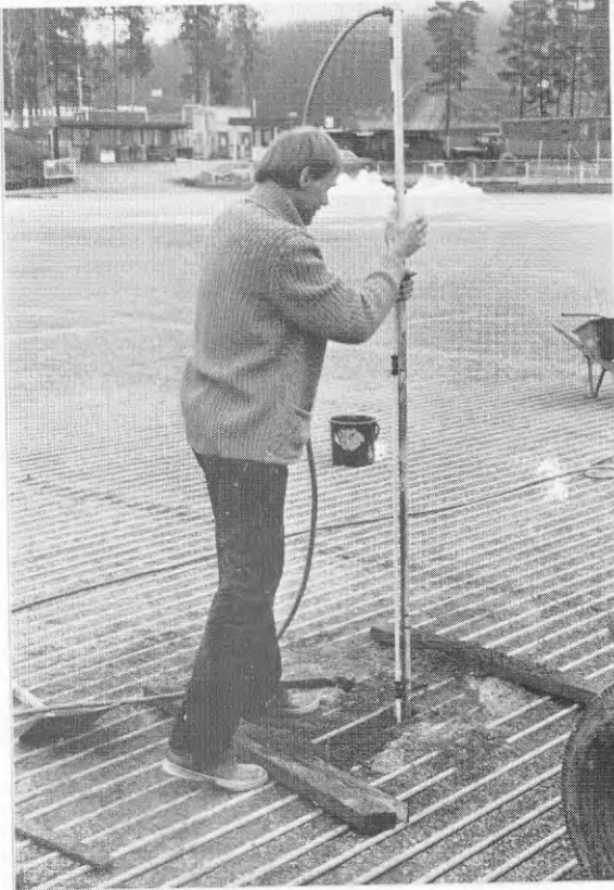
Fig 2.3 Mätcentralen för Energi- forskning har skött mät- värdesinsam- lingen. Här monteras jord- temperatur- givare i bandybanan.
