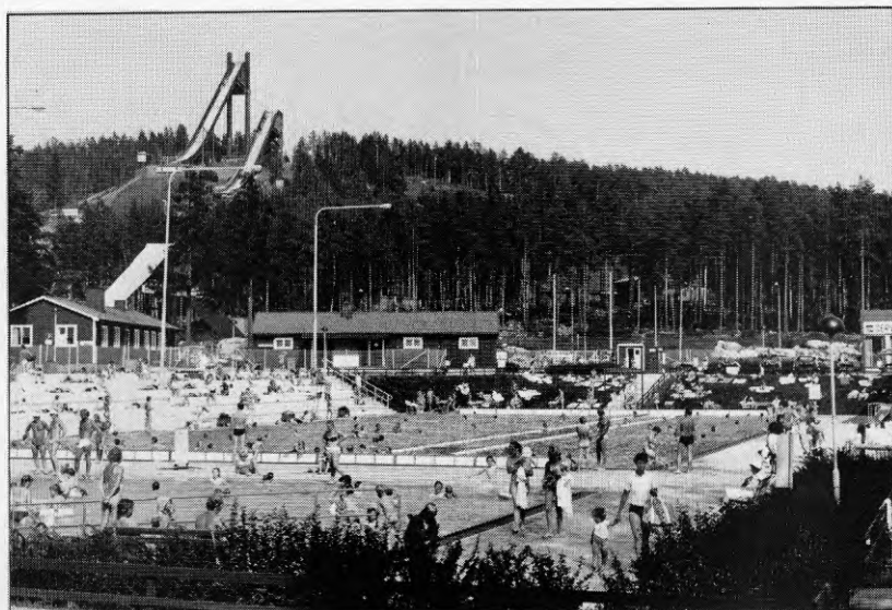
Fig 6.4 Vy över utomhusbadet med 25 m-bassängen i förgrunden. Bassängerna är utförda av helsvetsad rostfri stålplåt utan isolering mot mark.
