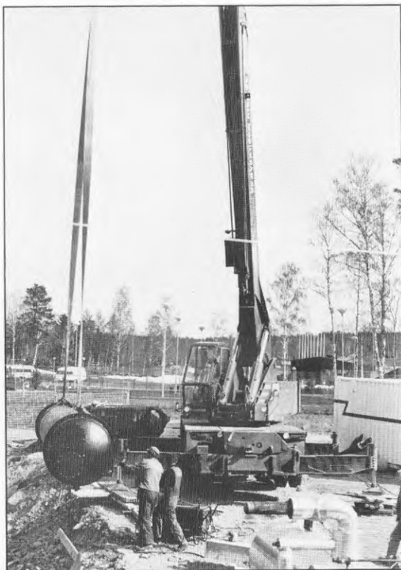
Fig 3.3 Kondensator KD2 lyfts på plats under byggnads- tiden.
