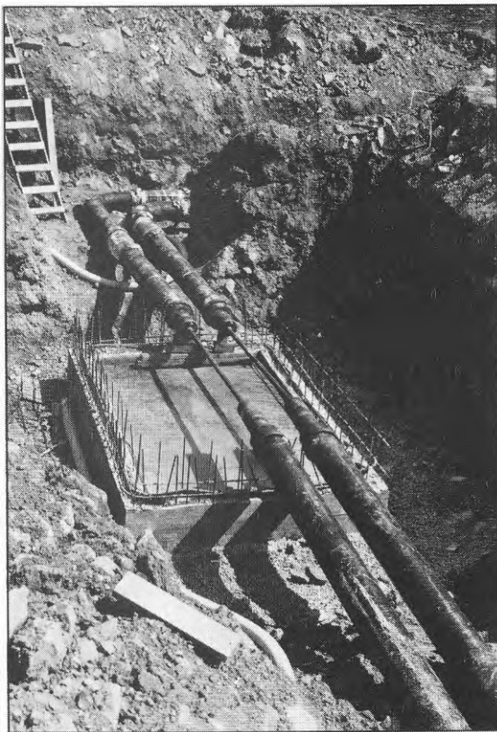
Fig 11.1 Kulvertledning ningar vid anslutningen till kulvert- brunnen.
