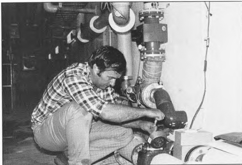
Fig 6.10 Flödesmätare FV581 var tyvärr ur funktion det första halvåret 1985. Felet var - som så ofta - smuts i spalten mellan vinghjul och mätarhus.
