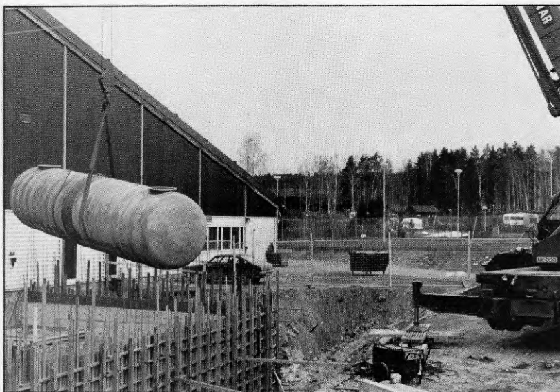
Fig 7.1 Den stora ackumulatortanken av glasfiberarmerad polyesterplast lyfts på plats innan valvet gjuts över maskinrummet. Ackumulatören är en gåva från ett företag i Falun.
