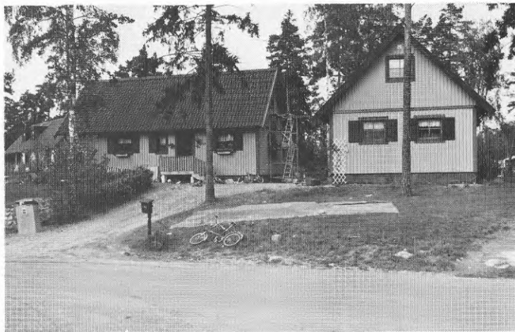
Figur 2.4. Exempel på hus i den första utbyggnadsetappen med inredd vind.
