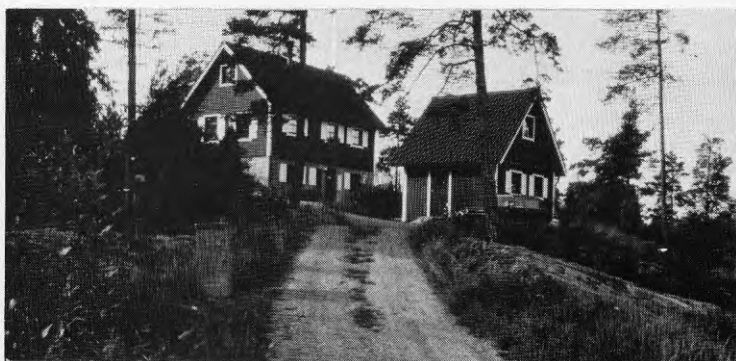
Figur 2.6 a. Den typiska höga tak- resningen tar till vara byggnadsytan maximalt.
