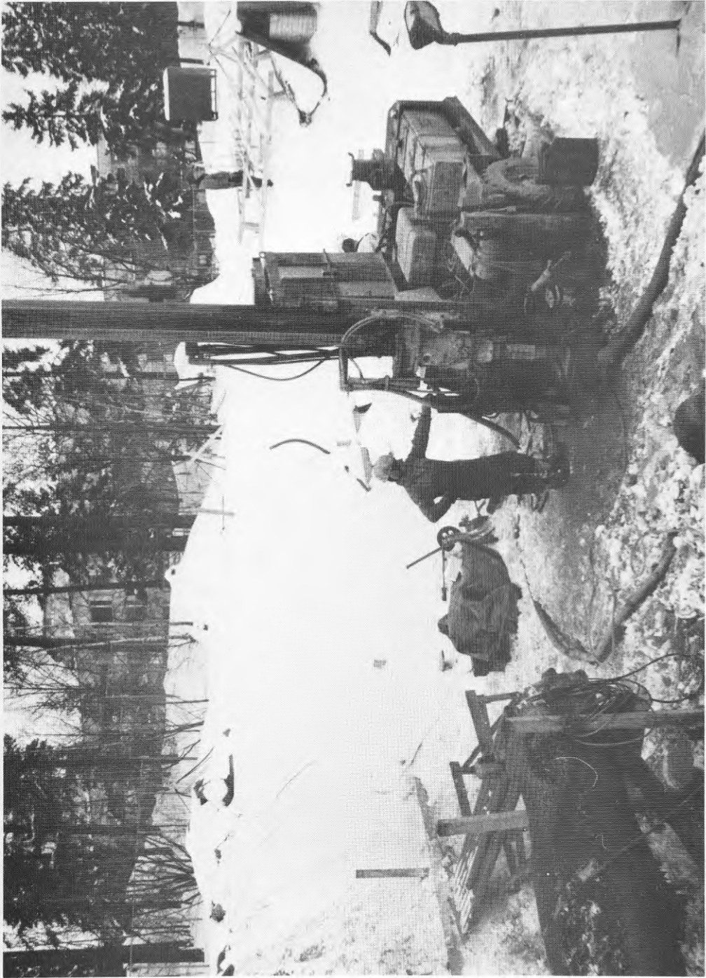
Figur 4.7 Borrning under vinterförhållanden, Nemek borrvagn.
