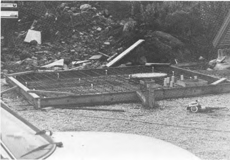
Separat gjutning av bjälklaget
