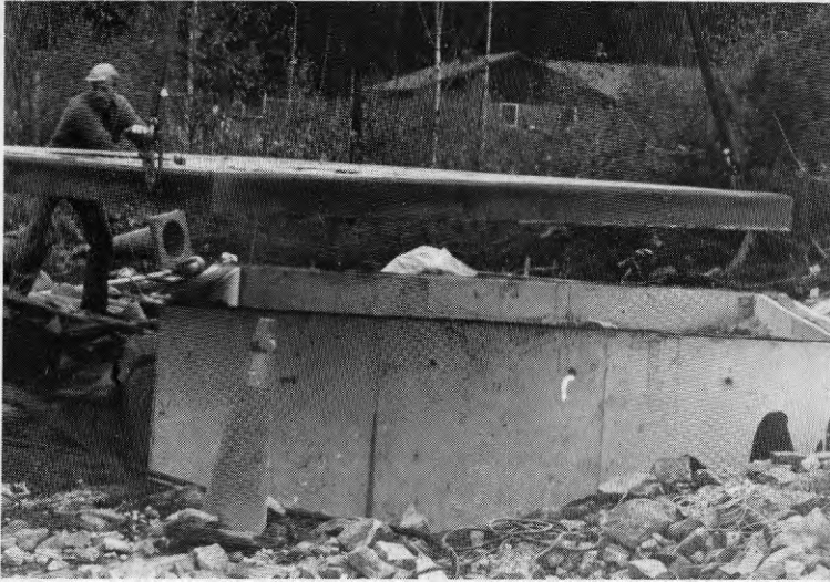
Bjälklaget lägges på plats ovan kant- väggarna.
