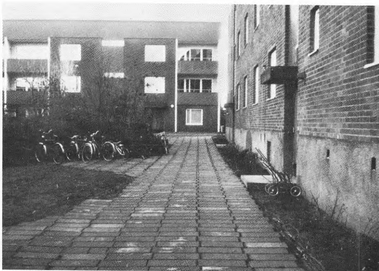
Berga: Entréside. Inga förändringar har gjorts förutom att asfaltgången är ersatt av betongplattor.
