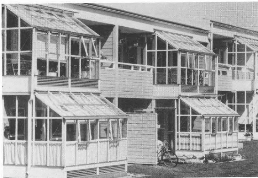
Närbild av några trapphuslägenheters glasverandor en solskensdag med öppna vädringsluckor och fällda solsnyddsgardiner. På eget initiativ har hyresgästerna i markplanslägenheterna satt upp "cafégardiner".
