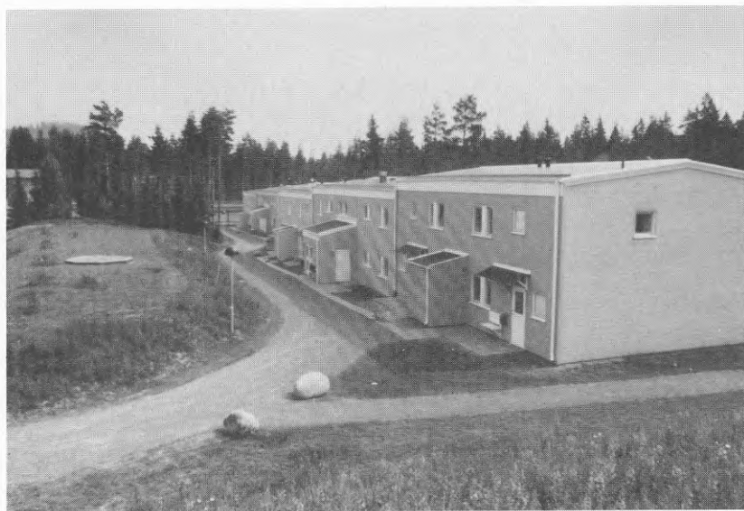
Entrésida mot norr. I det främre blocket inryms två tvåplanslägenheter på vardera sidan om det utskjutande förrådet. I mittblocket är det de fyra smålägenheternas trapphusentré som skjuter ut.
