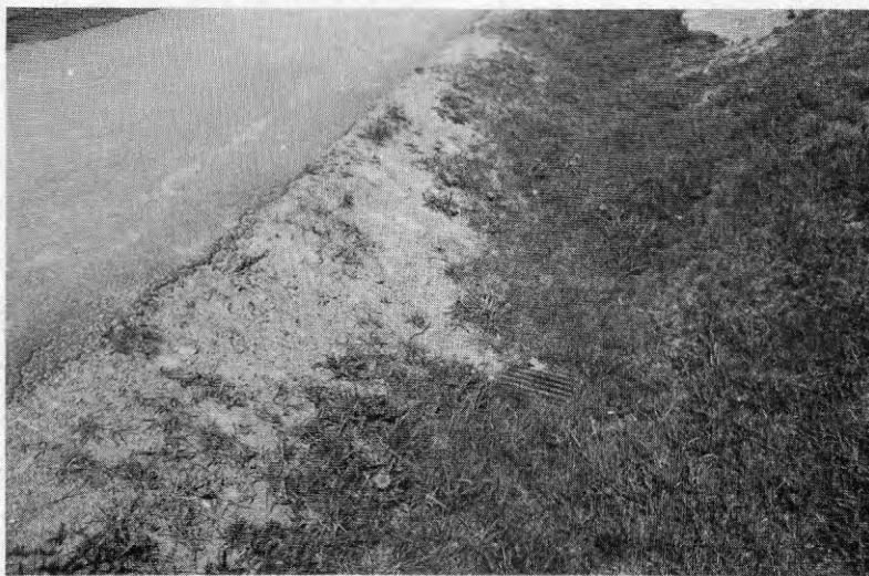
Erosion vid regnvattenbrunn delvis orsakad av för brant släntlutning, ca 1:1.
