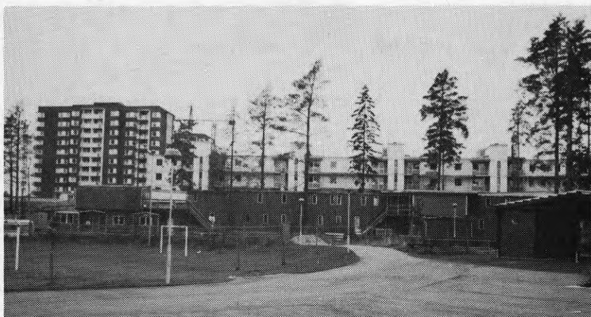
Fig 7. Där naturmarken utnyttjats som uppställningsyta för bodar etc. har skadorna på vegetationen blivit stora. I det här fallet har all markvegetation och nästan alla träd dött. (Invid yta 14)
