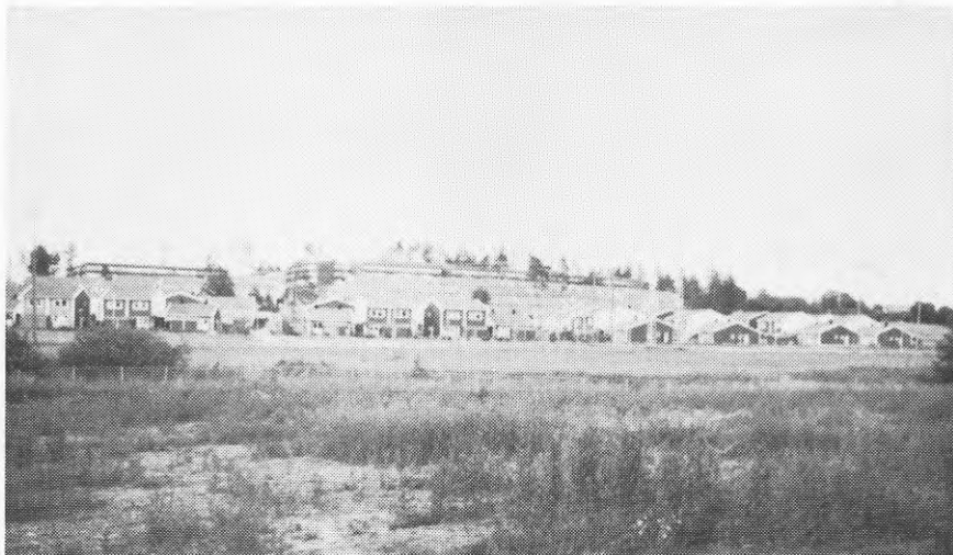
Fig. 49. Området där radhusen nu ligger var tidigare helt skogsklätt. Vegetationsförlusterna är lika stora vid småhus som vid storhus. Invid yta 12.
