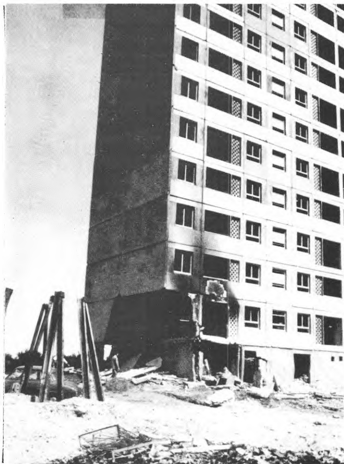
FIG 2.4 Byggnad efter bortfall av bärande element, men där skadan ej fortskridit, Algeriet [ 1 ] . En explosion i bottenvåningen har orsakat betydande skador i elementstommen utan att ovanförliggande byggnadsdelar skadats.
