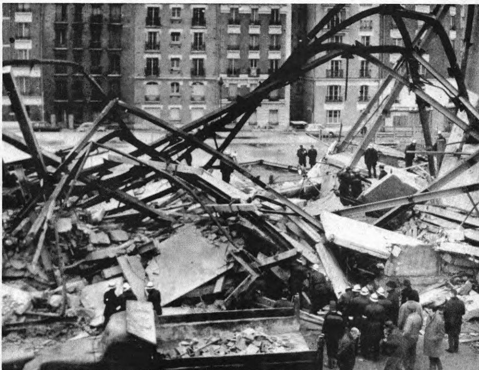
FIG 2.3 Stålbärverk helt raserat efter fortskridande skada, Paris 1964 [1]. Flervåningsbyggnaden som var under uppförande och nästan färdig rasade långsamt och nästan ljudlöst samman till en hög av betong och stålrester.
