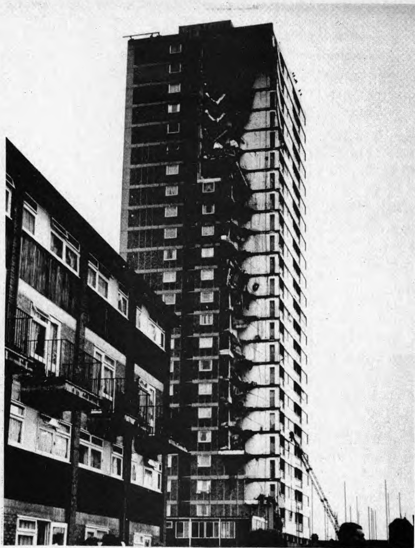
FIG 2.1 Byggnadsraset i Ronan Point, London 1968 [1]. En explosion inträffade i 18:e våningen av det 22 våningar höga huset. Denna skada spred sig därefter längs hela hörnsidan.
