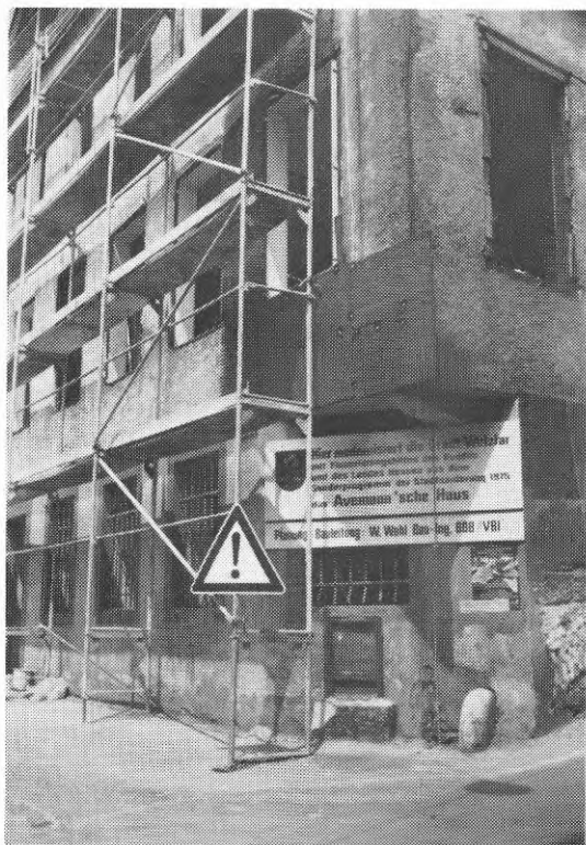
Utvändig renovering av kulturhistoriskt värdefull byggnad i Wetzlar, Västtyskland (1976). Heltäckande tilläggsisolering med mineralull + nätarmering som underlag för mineralisk puts. Isoleringentreprenör Grünzweig & Hartmann AG. Ludwigshafen.
