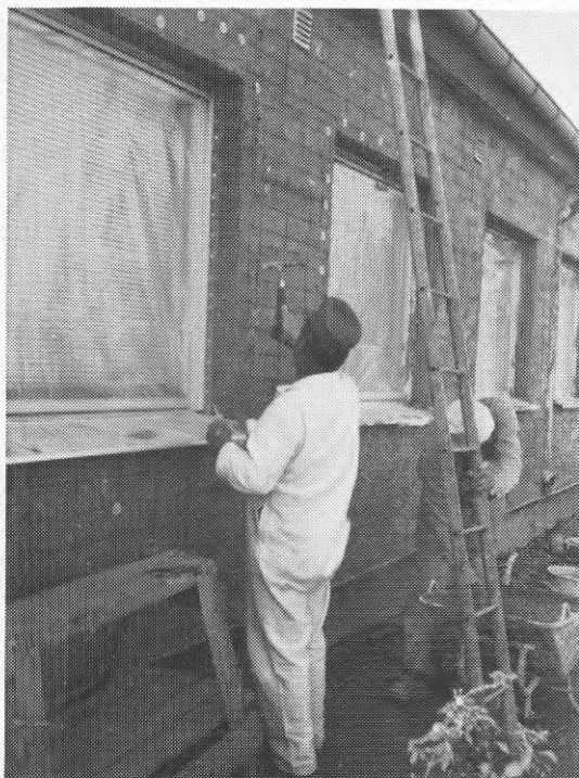
Putsning på utvärdig tilläggsisolering av kontorsbyggnad i Skövde (1976). Heltäckande isolering med 100 mm mineralull. Som led i pågående metodutveckling provades bl a olika slag av putsarmering och infästningselement för denna (se vidare pkt 4.61).
