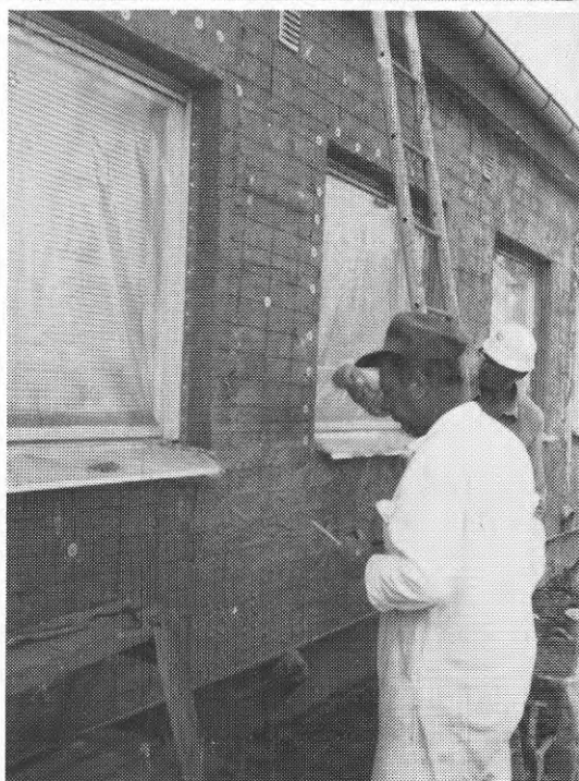
Putsning på utvärdig tilläggsisolering av kontorsbyggnad i Skövde (1976). Heltäckande isolering med 100 mm mineralull. Som led i pågående metodutveckling provades bl a olika slag av putsarmering och infästningselement för denna (se vidare pkt 4.61).
