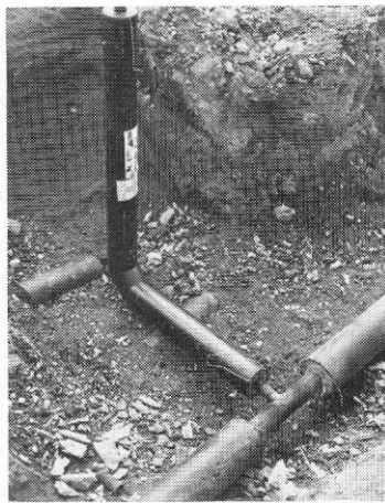
Figur 3.9 och 3.10 Bilderna visar markkulvertsystemet i anläggningsfasen. De många avsticken och böjarna leder till stora krav på kontroll av arbetets utförande. Glöm inte bort larmsystemet.
