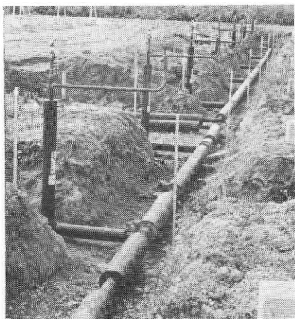
Figur 3.9 och 3.10 Bilderna visar markkulvertsystemet i anläggningsfasen. De många avsticken och böjarna leder till stora krav på kontroll av arbetets utförande. Glöm inte bort larmsystemet.
