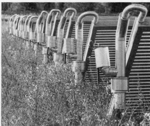
Figur 4.2 och 4.3 Säkerhetsventiler för varje rad om 10 solfångare totalt 32 st. Varje rad är försedd med inregleringsventil för att kunna justera flödet.
