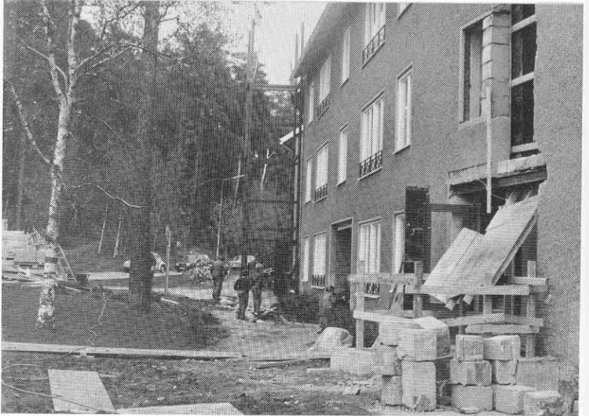
Förtillverkade stålstommar användes till "hisstornen".
