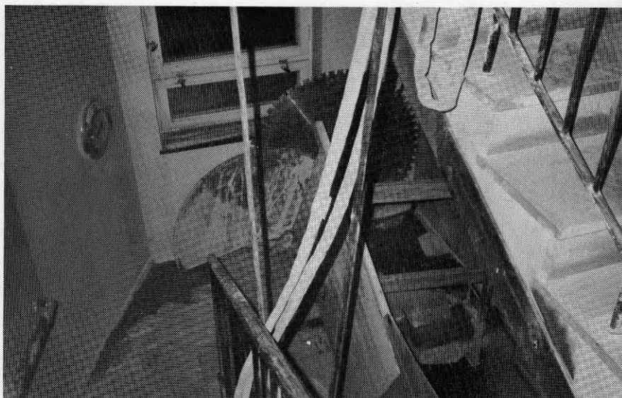
Figur 9.4 De sågade trapplöpen flyttades och förstärktes med stålbalkar
