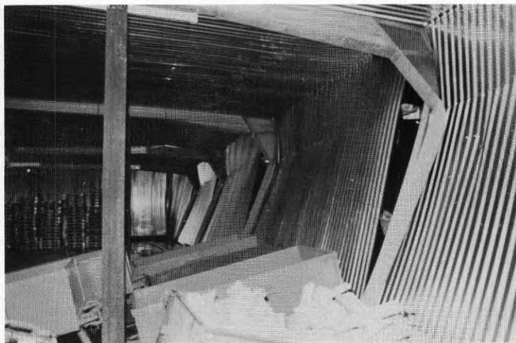
Fig. 5 Utknäckt innerfläns på pelare
