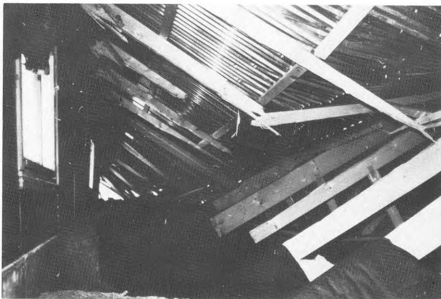
Fig. 4 Nedrasade fackverkstakstolar
