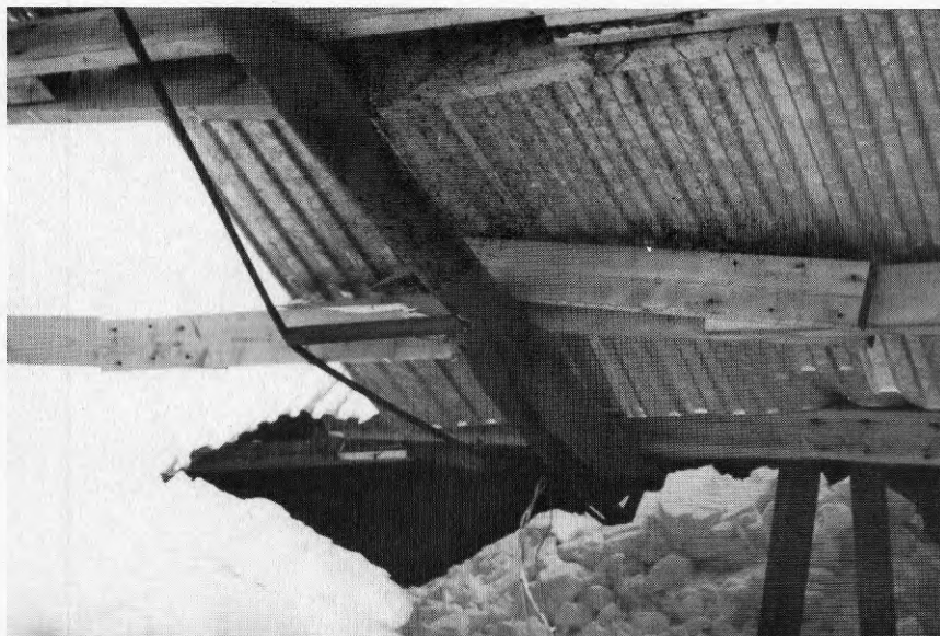
Fig. 2 Fackverksbalk som vippat
