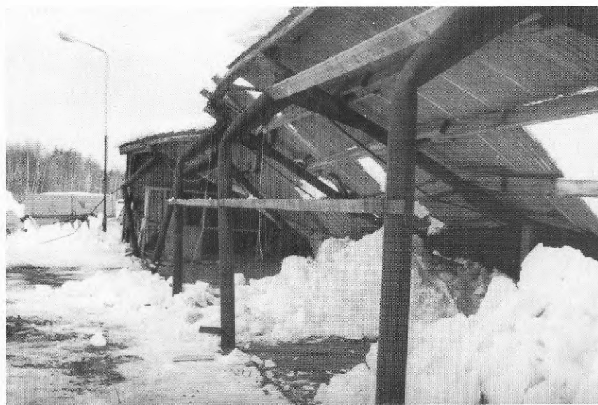
Fig. 3 och 4 Taket med böjda pelare
