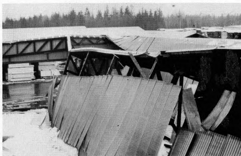
Fig.2 Nerkanad takskiva av åsar och plåt
