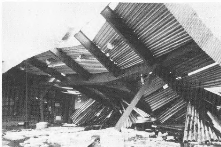
Fig.3 Det rasade taket
