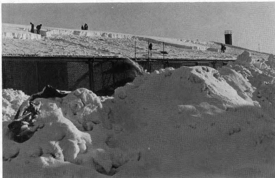
Fig.3 Snöskottning på taket
