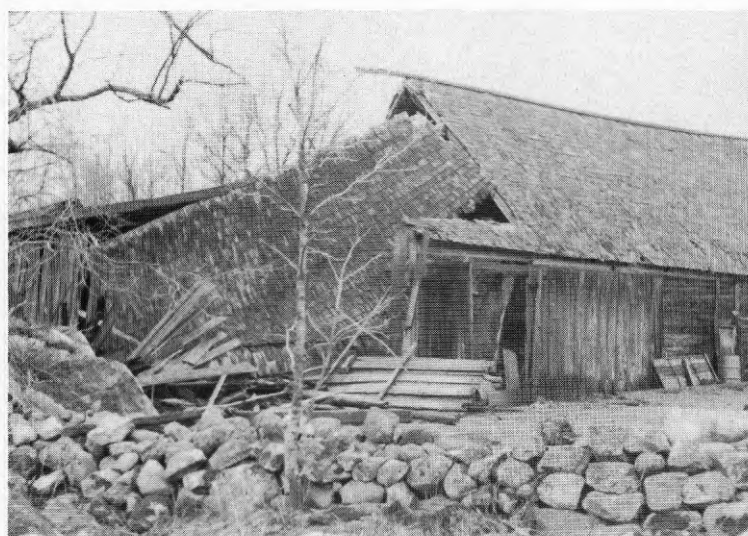
Fig. 3.3 Ras i ladugård. Stolpverk av timmer med utvändig brädforning.
