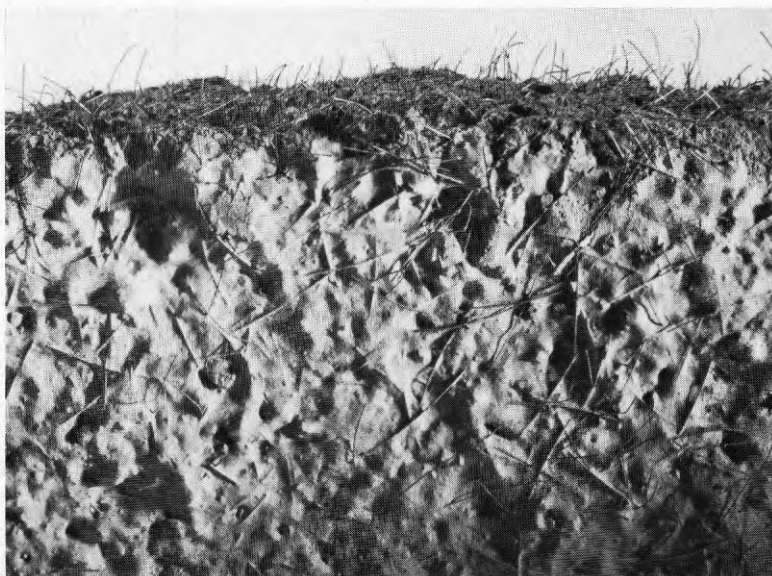
FIG. 7. Detalj av brottyta och del av framsida på provplatta av fiberbetong. Detail of fracture and part of front on test panel of fibre concrete.
