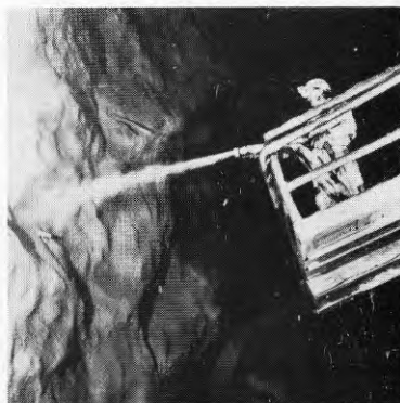
FIG. 14. Förstärkning av schakt i oljelagringsanläggning. Reinforcement of shaft, rock room for oil storage
