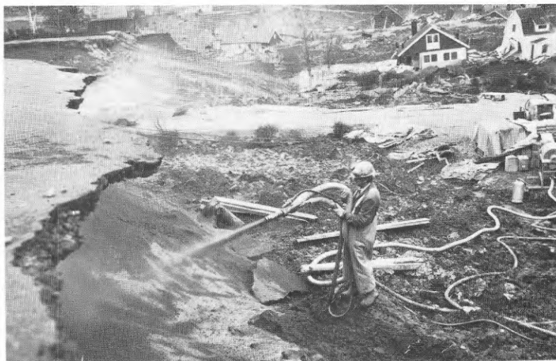
FIG. 12. Stabilisering av lerslänter, Tuveskredet. Stabilization of clay slopes at the Tuve catastrophe.
