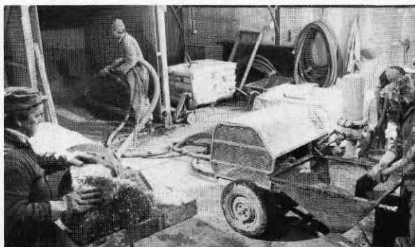
FIG. 19. Sprutning av provplattor med Putzmeister PKS och Fibre feeder 50/75. Spraying of test panels with a Putzmeister PKS and a Fibre feeder 50/75.
