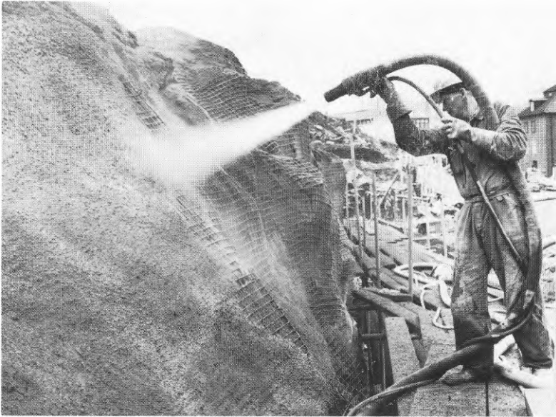
FIG. 2. Förstärkning av bergslänt med torrspjutningsmetoden. Reinforcement of a rock slope with dry mixed shotcrete.
