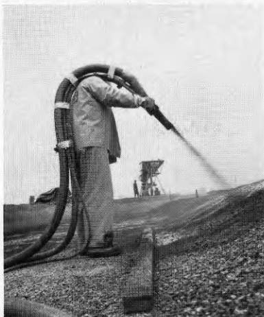
FIG. 13. Tätning med fiberbetong i vattenkanal. Sealing with fibrous shotcrete, water channel
