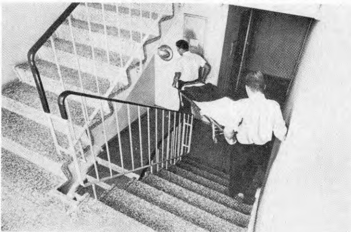
U-formade tvåloppstrappor är svårare att passera med bär. I avsikt att kunna eliminera bären som dimensionerande faktor konstruerades en ny flexibel bär. Bären var alltså fällbar och klarade svåra passager. Den har väckt ett visst intresse, men har inte bidragit till att ändra det svenska kravet på att allmänna trappor och trapphus anpassas för bärbarning.
