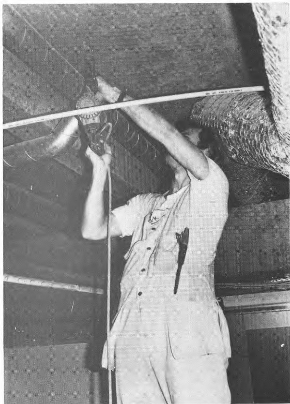
Figur 4. Borrning vid undertaksmontage.
