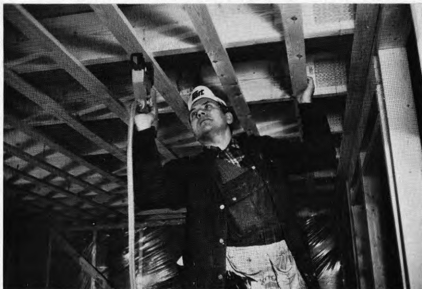
Figur 2 b. Maskinspikning av glespanel.
