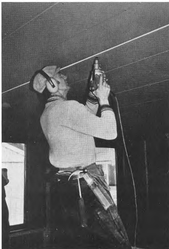
Figur 3. Skruvning av gipsplattor i tak.
