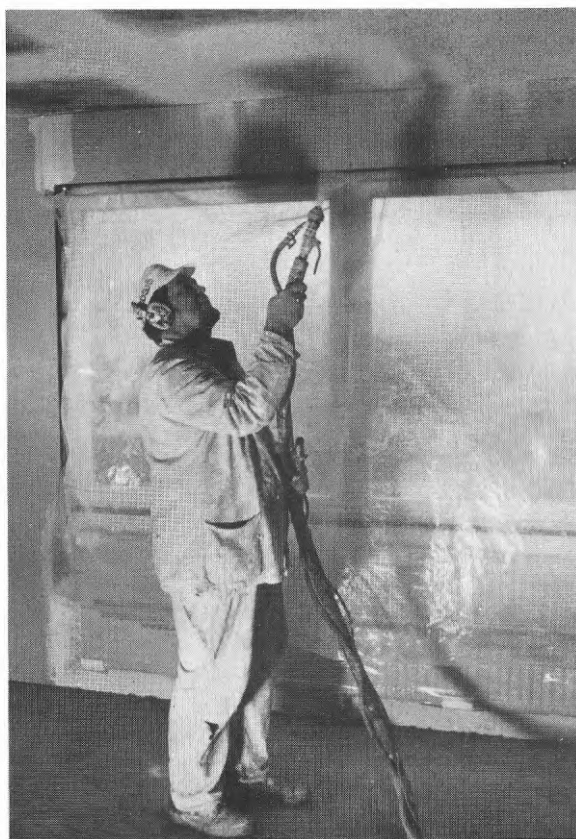
Figur 6 a. Sprutning av sandspackel i tak.
