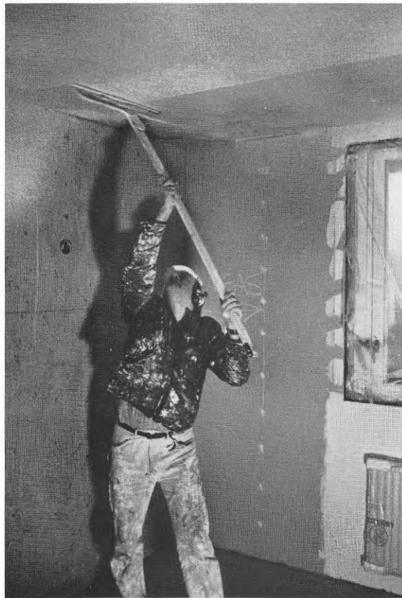
Figur 6 b. Slätning av sandspackel i betongtak.
